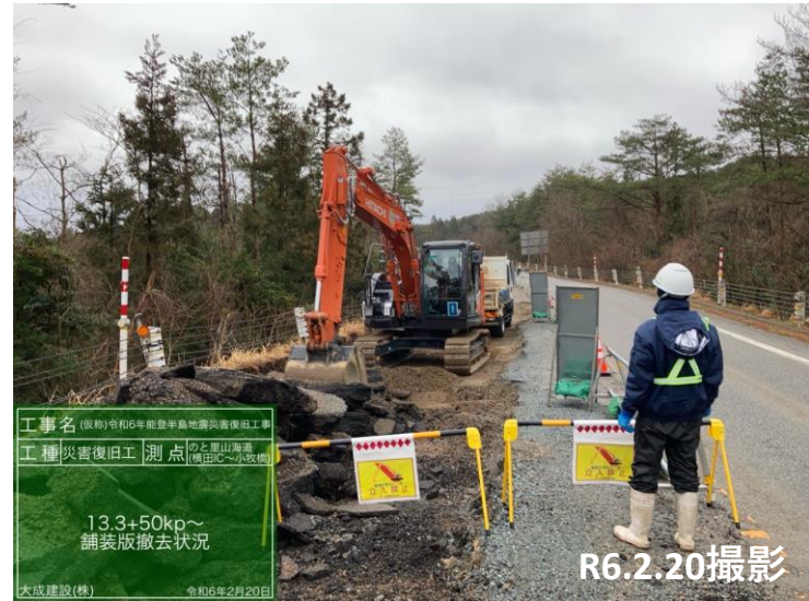
No.10 舗装撤去状況
