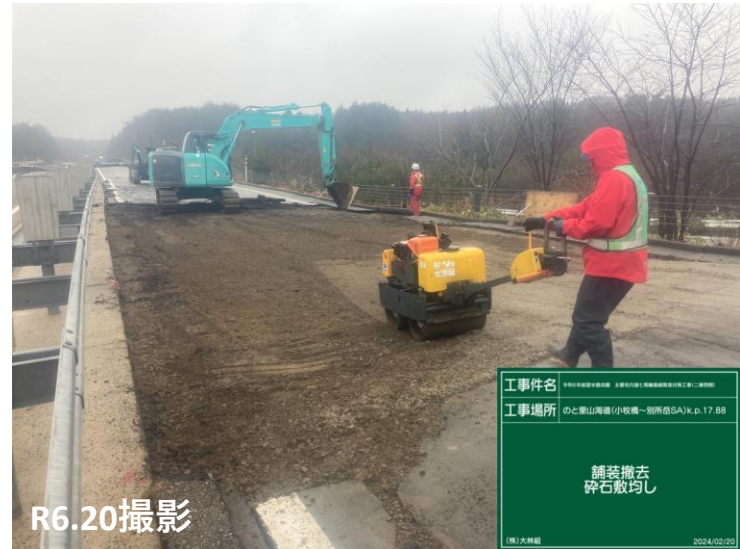
No.44 碎石敷均し状況
