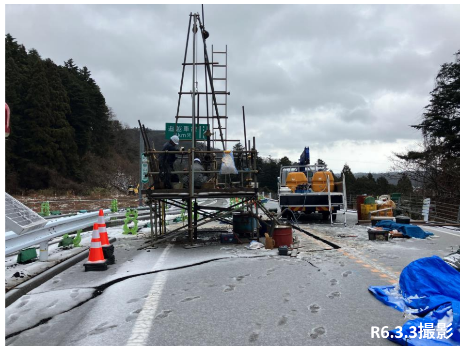
No.18 ボーリング調査状況
