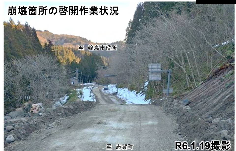
崩壊箇所の啓開作業状況
