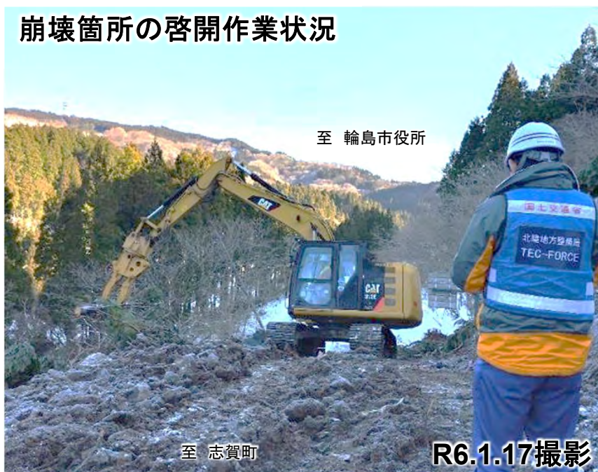
崩壊箇所の啓開作業状況
