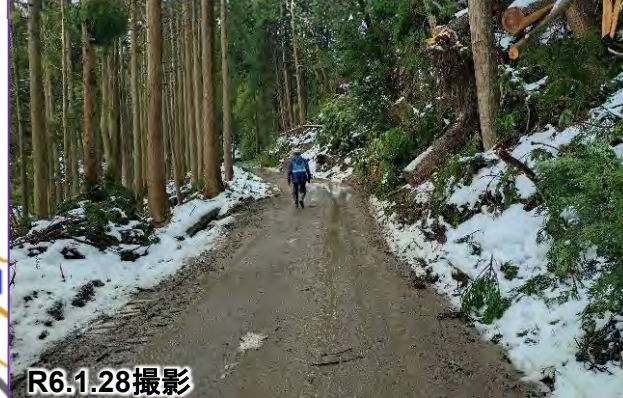
啓開作業状況 (崩落箇所を迂回するルートを整備)
