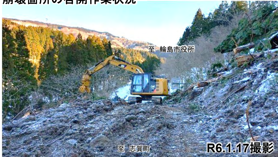
崩壊箇所の啓開作業状況
