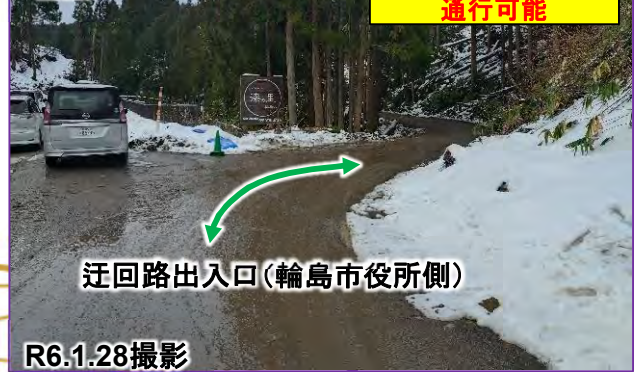
啓開作業状況 (崩落箇所を迂回するルートを整備)
