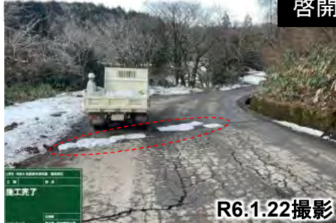
舗装損傷箇所を啓開状況
