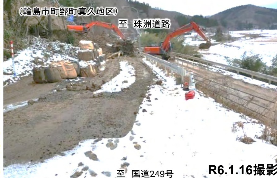
④崩壊箇所の啓開後の状況
