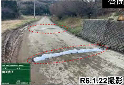
舗装損傷箇所を啓開状況
