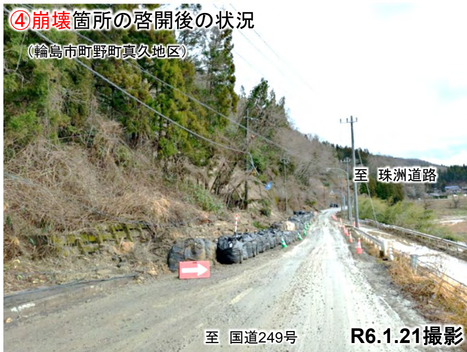
④崩壊箇所の啓開後の状況
