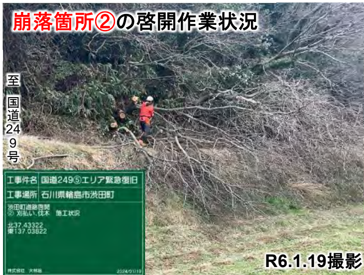
崩落箇所②の啓開作業状況
