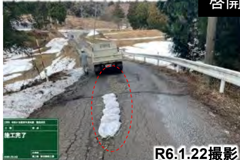
舗装損傷箇所を啓開状況
