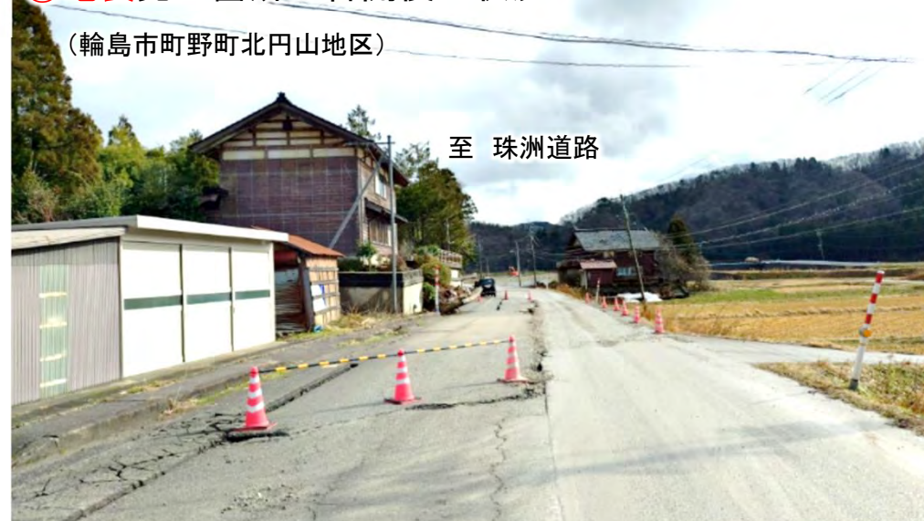
②亀裂発生箇所の啓開後の状況
