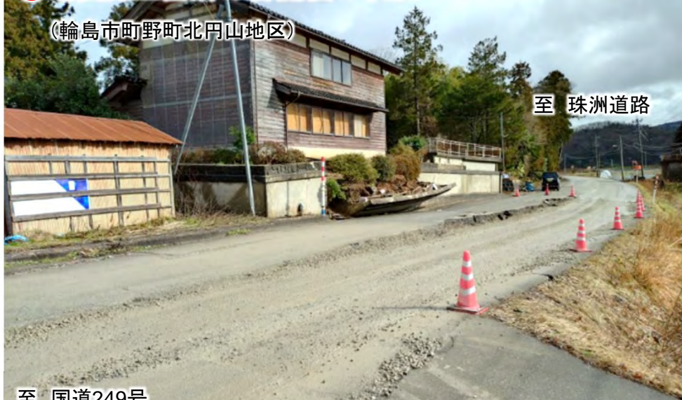
②亀裂発生箇所の啓開後の状況
