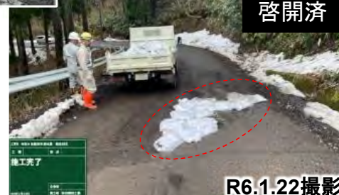
舗装損傷箇所を啓開状況
