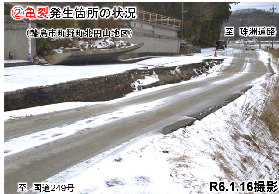
②亀裂発生箇所の啓開後の状況
