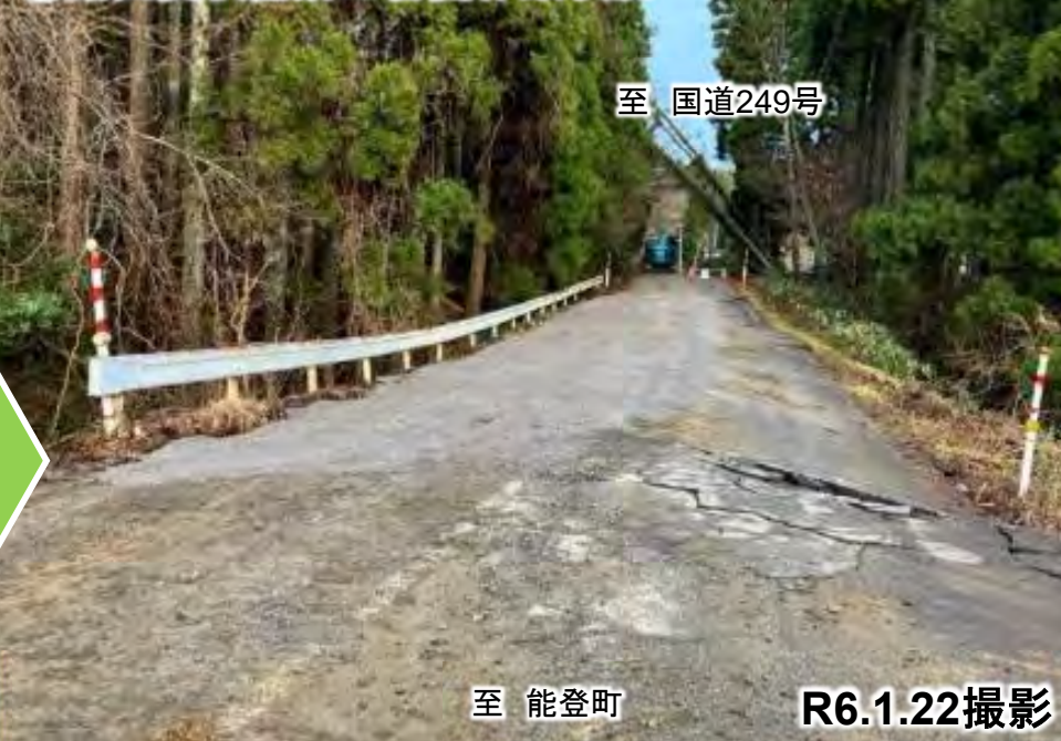
⑦路面変状箇所の啓開作業状況
