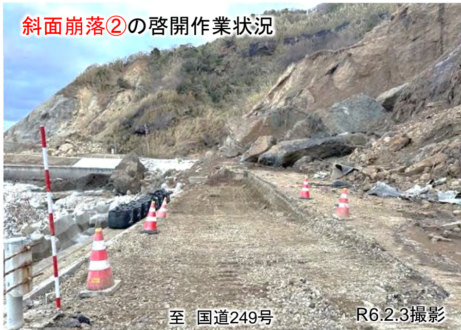
斜面崩落②の啓開作業状況
