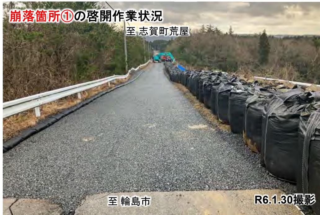
崩落箇所①の啓開作業状況
