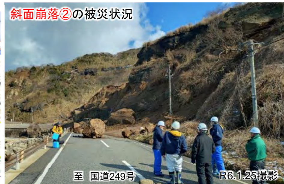
斜面崩落②の被災状況
