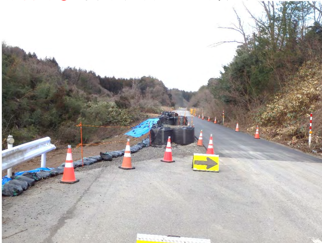
崩落箇所②の啓開後、志賀町による舗装工事後の状況
