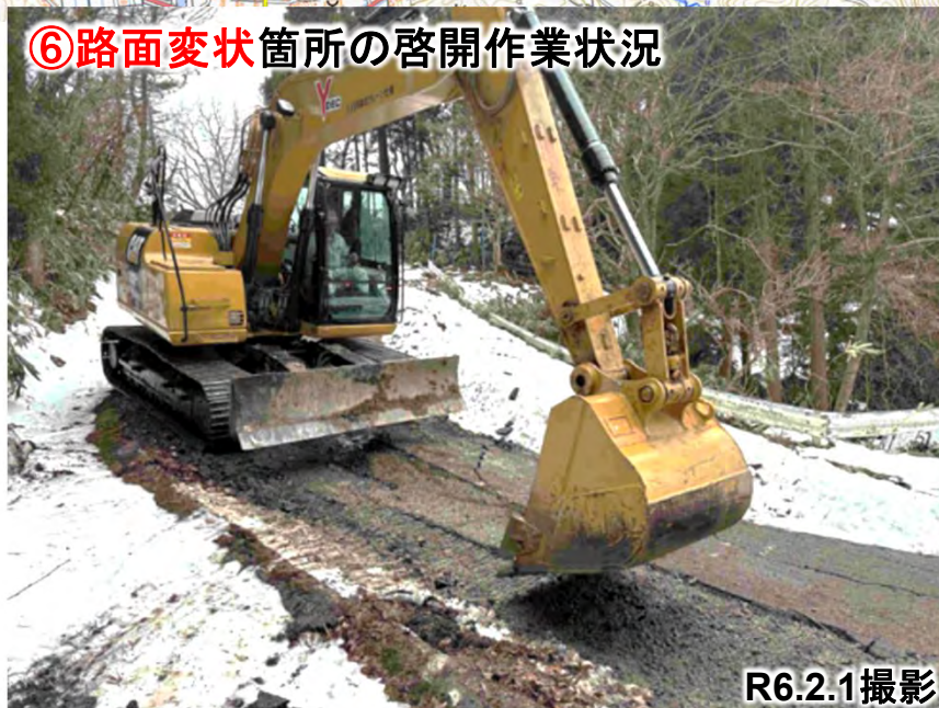
⑥路面変状箇所の啓開作業状況
