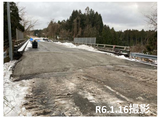
No.51 段差擦り付け
