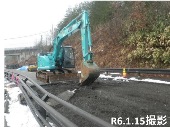
No.6段差復旧状況
