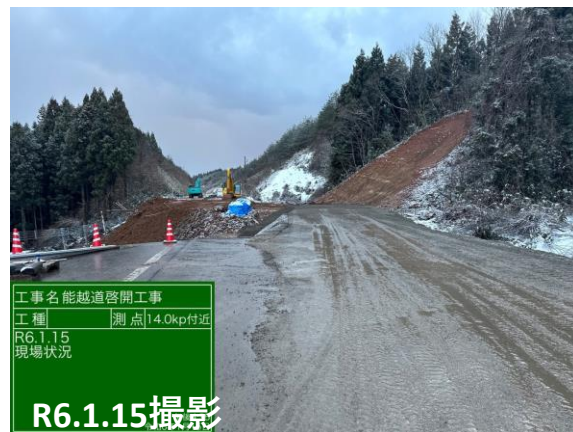
No.16 法面切土
