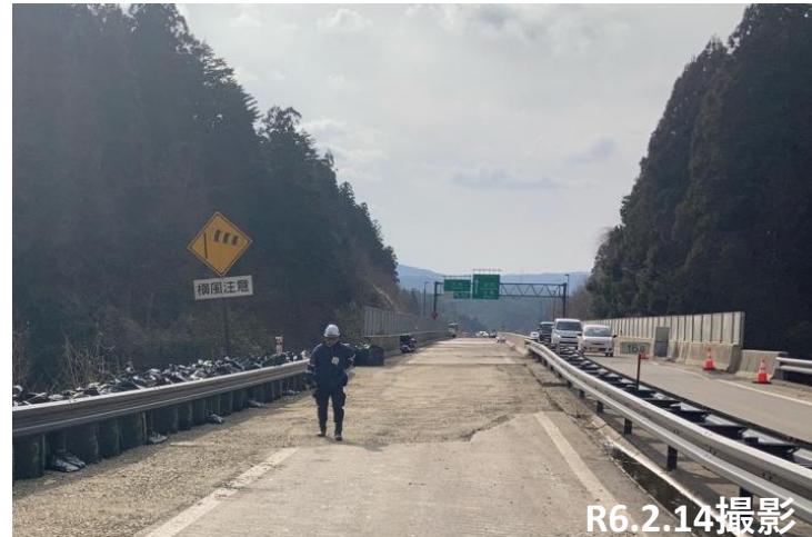
No.40 砕石敷均し状況
