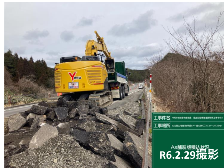
No.35付近 舗装撤去状況
