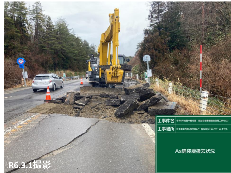
No.26付近 舗装撤去状況
