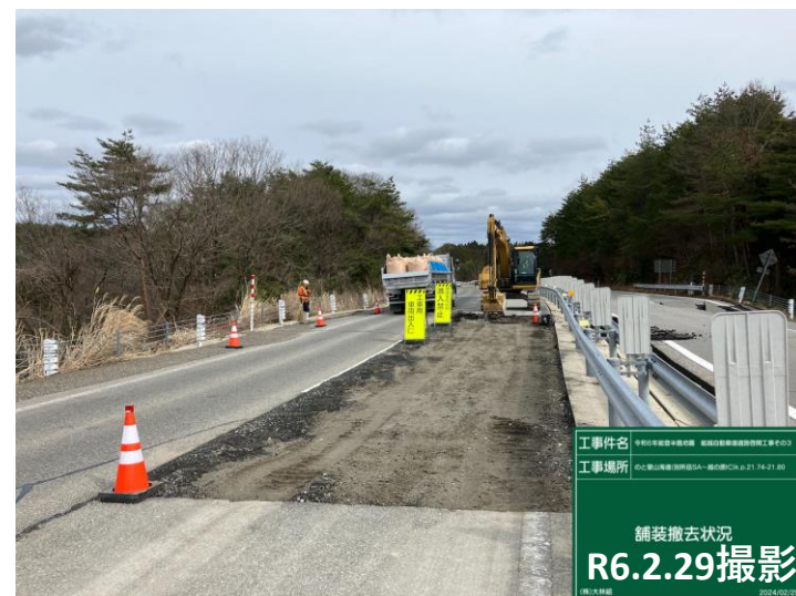
No.35付近 舗装撤去状況
