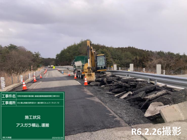
No.34付近 アスガラ積込・運搬状況
