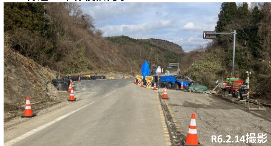
No.29付近 1車線復旧完了
