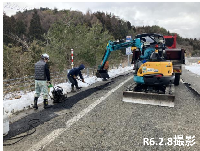
No.4付近 亀裂・段差補修状況
