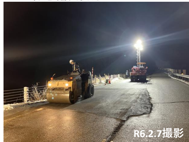
No.34付近 舗装状況
