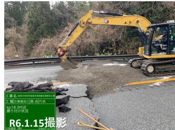
No.56 段差擦り付け
