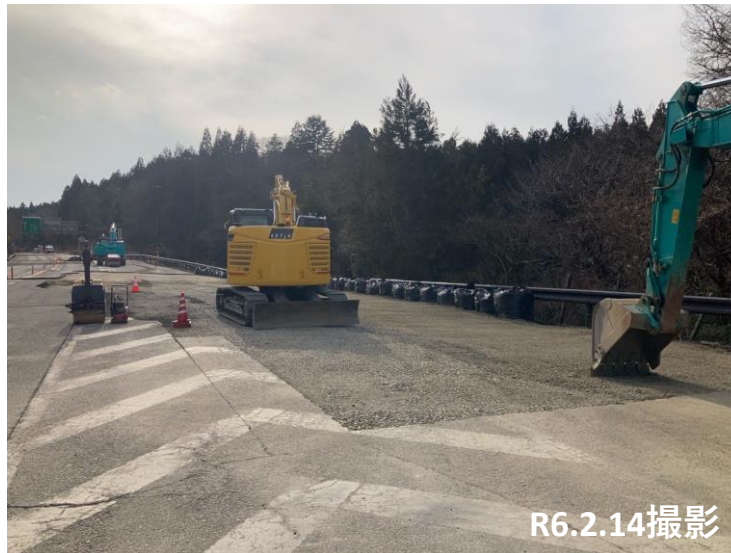
No.56 舗装撤去・砕石埋戻し
