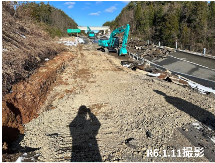
No.15 碎石充填状況
