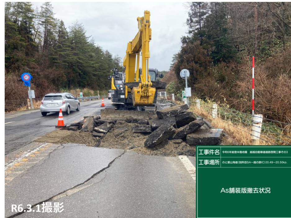
No.26付近 舗装撤去状況
