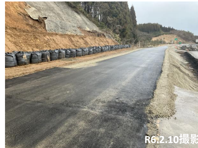
No.29 路盤整備およびAs舗装完了
