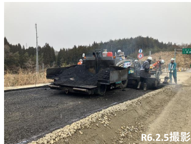
No.29～30付近 舗装施工状況
