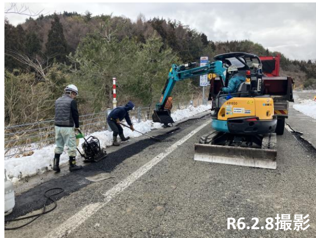
No.4付近 亀裂・段差補修状況
