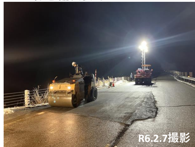
No.34付近 舗装状況
