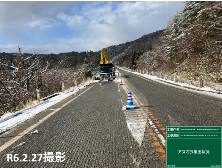
No.34付近 アスガラ積込・運搬状況
