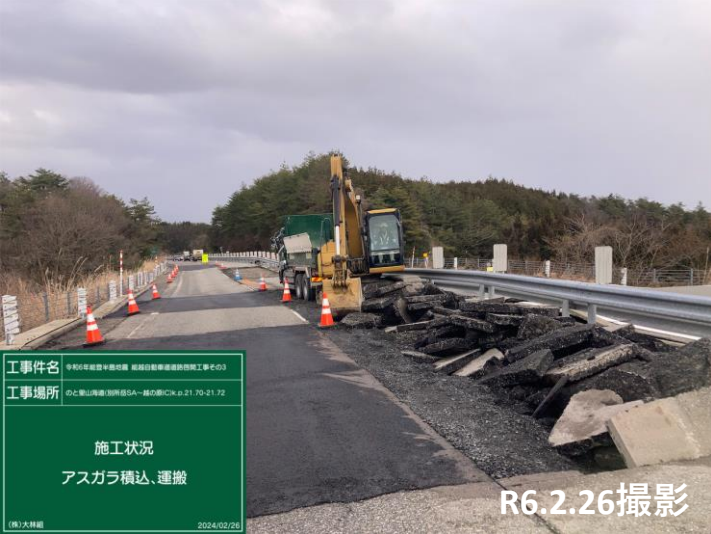
No.34付近 アスガラ積込・運搬状況
