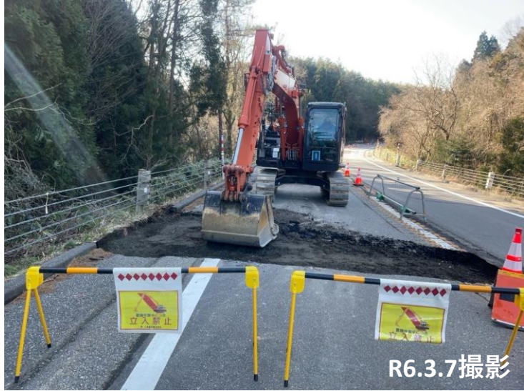
No.8 舗装撤去状況
