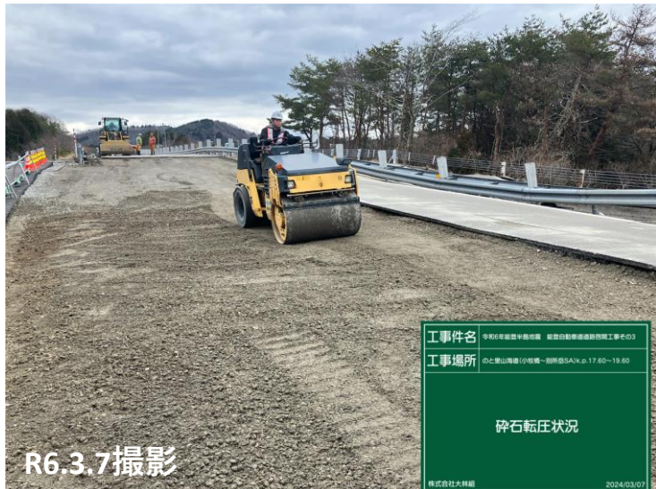
No.44 碎石敷転圧状況
