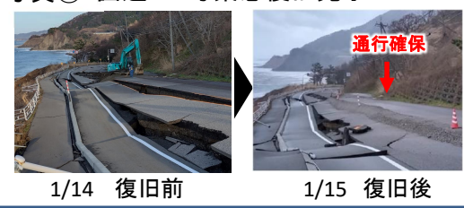
写真② 国道249号緊急復旧完了
