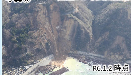
写真③ 国道249号法面崩落
