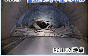
写真① 国道249号中屋トンネル
