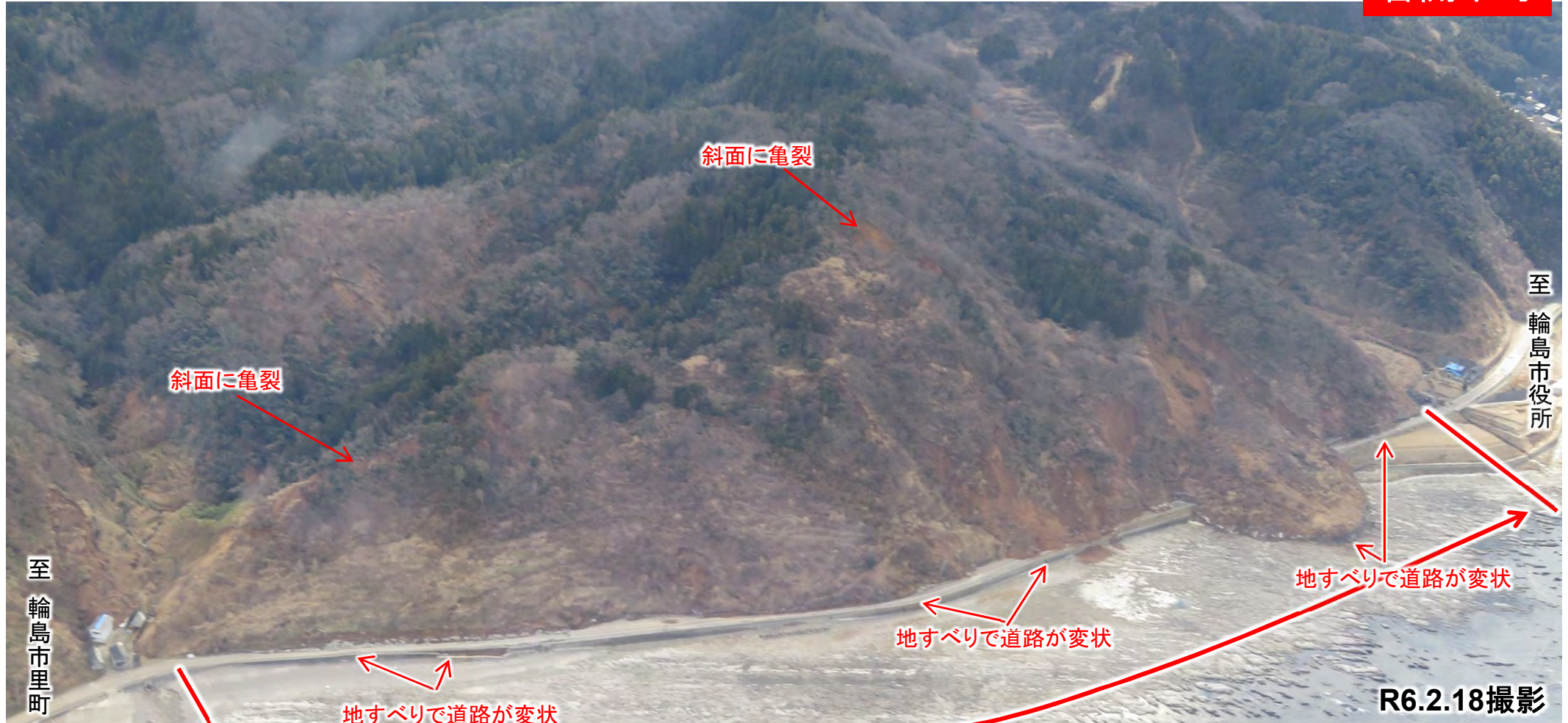
地すべりによる斜面変状・崩落箇所
