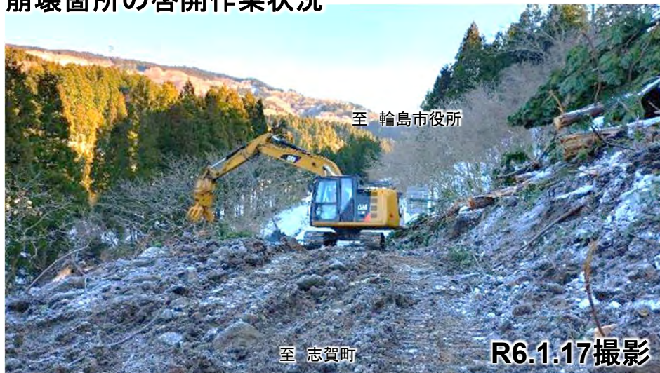
崩壊箇所の啓開作業状況
