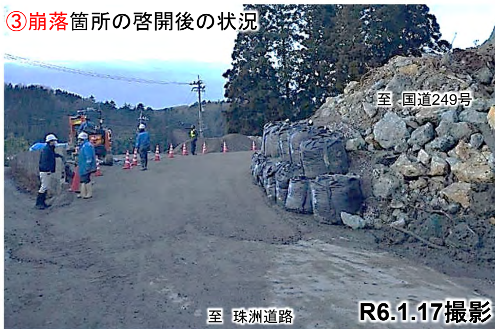
③崩落箇所の啓開後の状況
