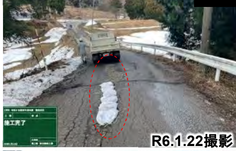
舗装損傷箇所を啓開状況 啓開済
