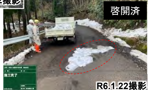
舗装損傷箇所を啓開状況
