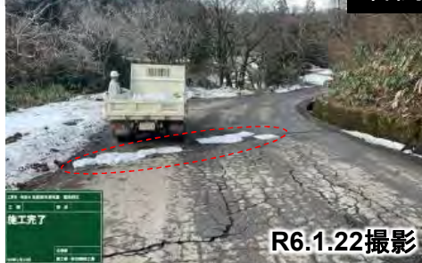
舗装損傷箇所を啓開状況 啓開済
