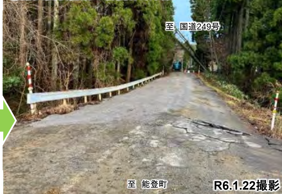
⑦路面変状箇所の啓開作業状況
