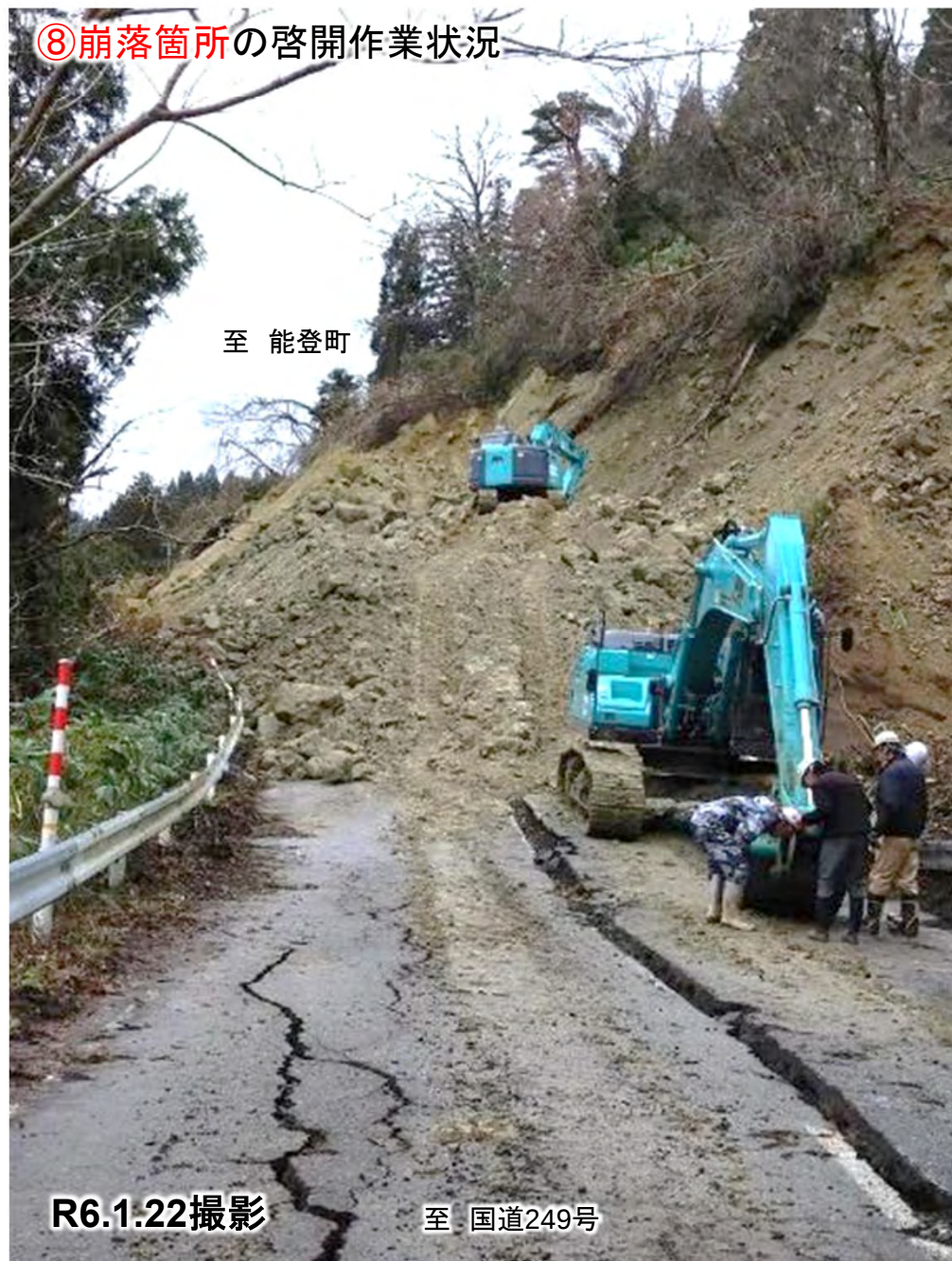
⑧崩落箇所の啓開作業状況
