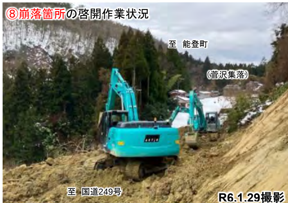
⑧崩落箇所の啓開作業状況
