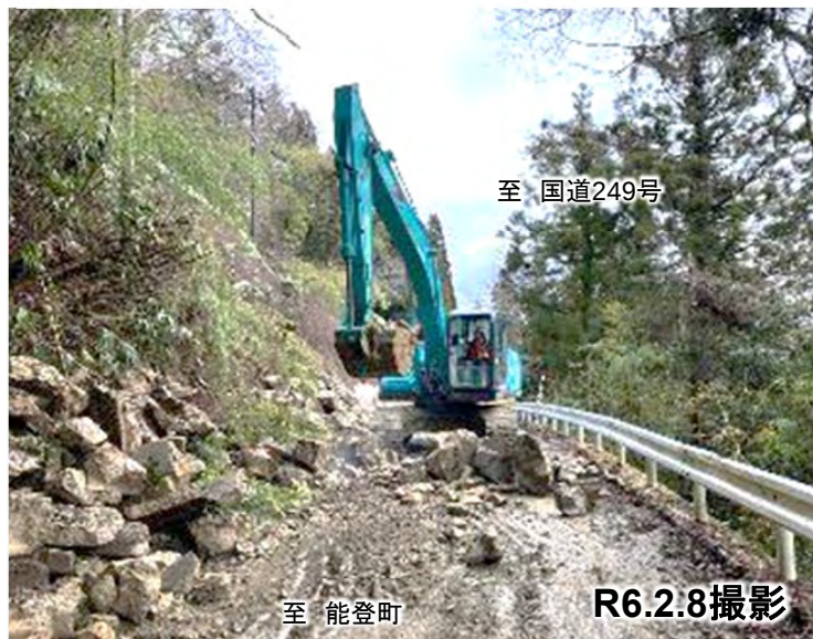
⑨崩落箇所啓開作業状況
