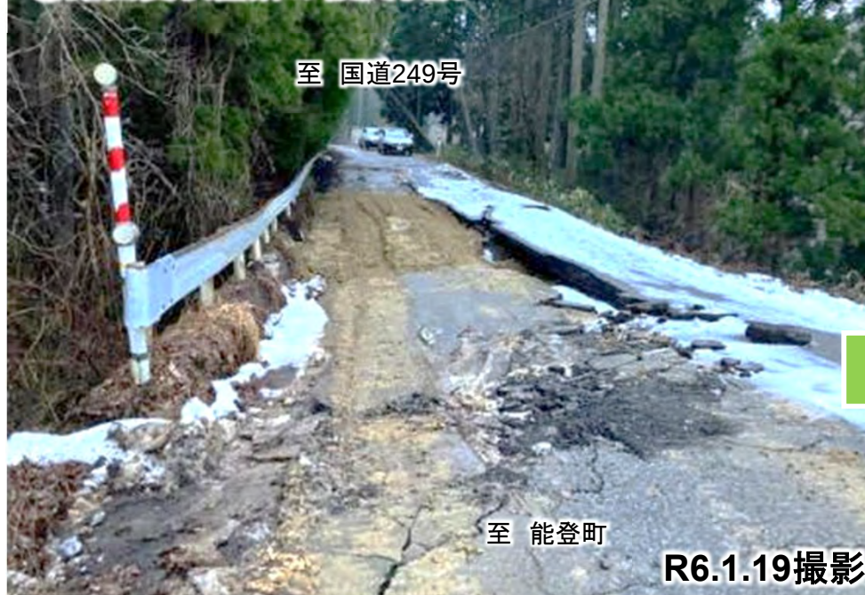
⑦路面変状箇所の被災状況
