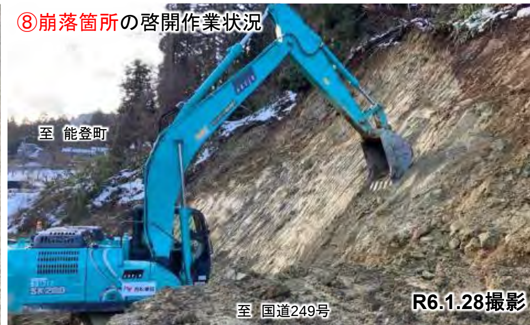
⑧崩落箇所の啓開作業状況
