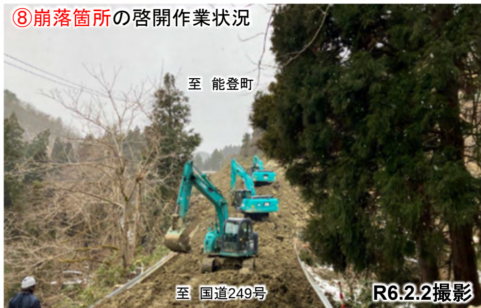
⑧崩落箇所の啓開作業状況
