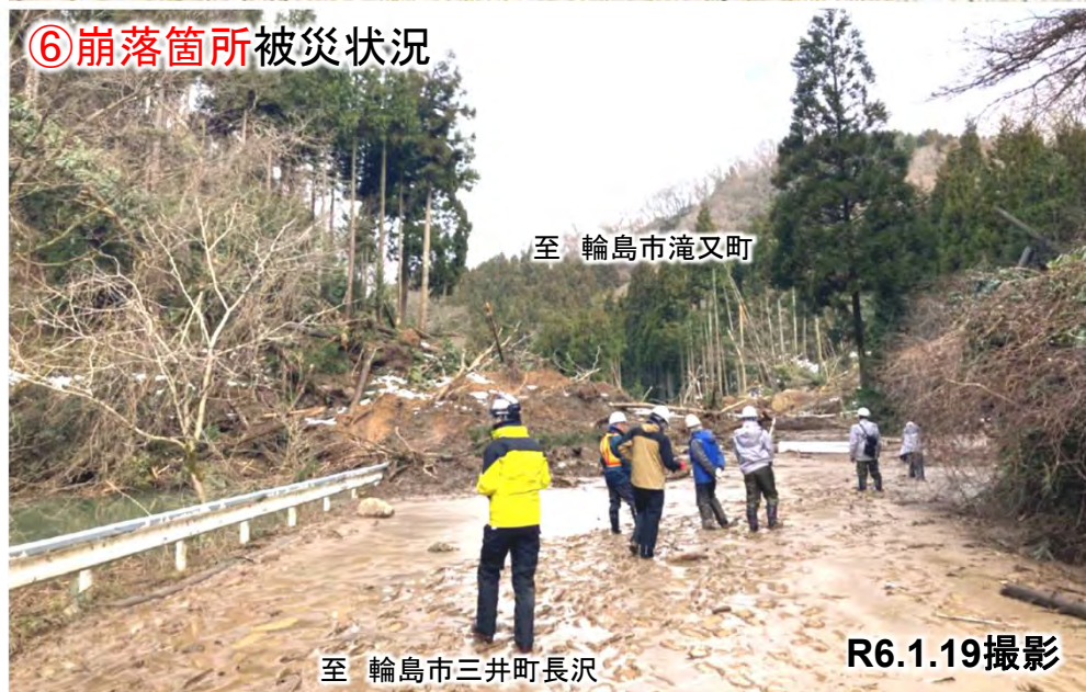
⑥崩落箇所啓開作業状況
