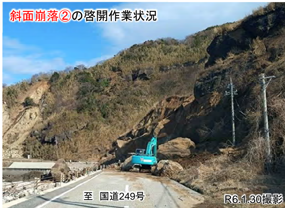
斜面崩落②の啓開作業状況
