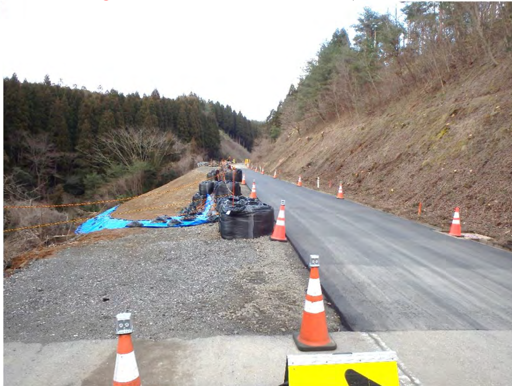
崩落箇所③の啓開後、志賀町による舗装工事後の状況
