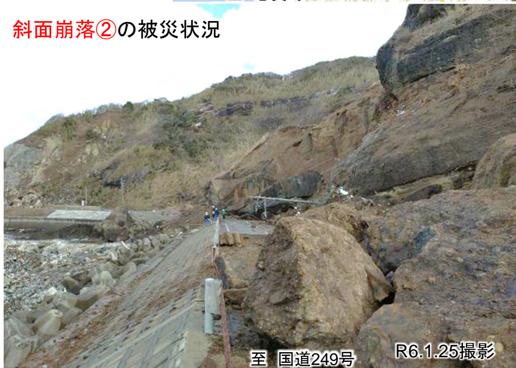
斜面崩落②の被災状況
