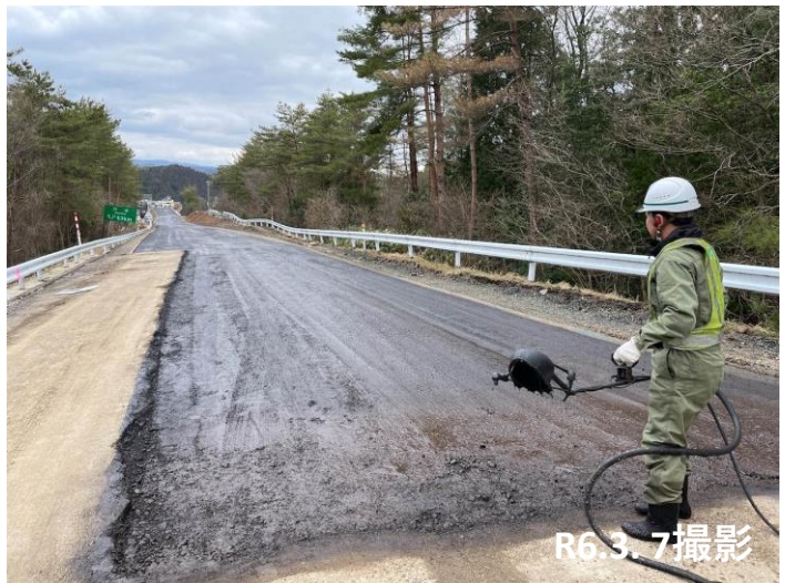
No. 45 舗装工乳剤散布施工状況
