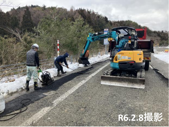
No.4付近 亀裂・段差補修状況
