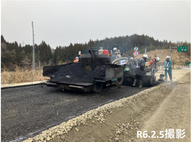
No.29～30付近 舗装施工状況
