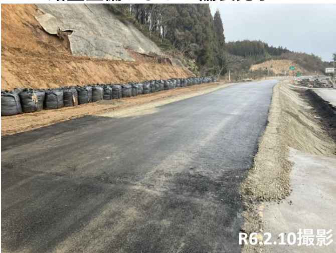
No.29 路盤整備およびAs舗装完了
