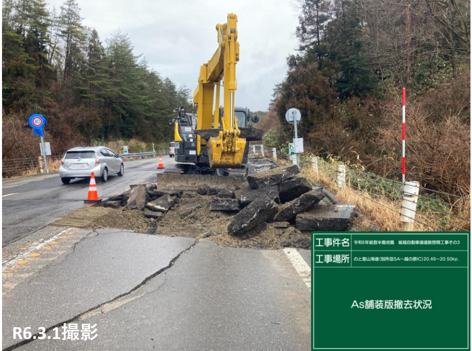
No.26付近 舗装撤去状況
