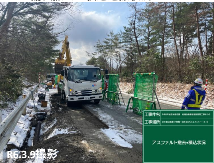
No.14舗装撤去 積込運搬状況
