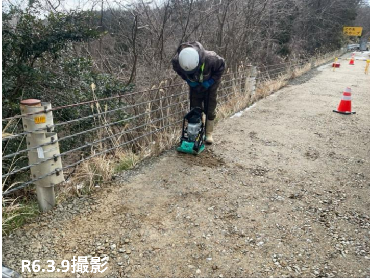
No.9 碎石敷均し状況
