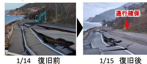
写真② 国道249号緊急復旧完了
