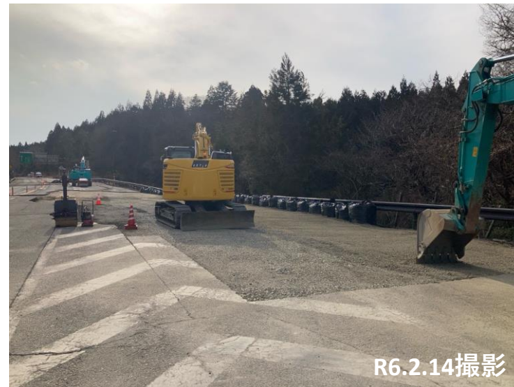
No.56 舗装撤去・砕石埋戻し
