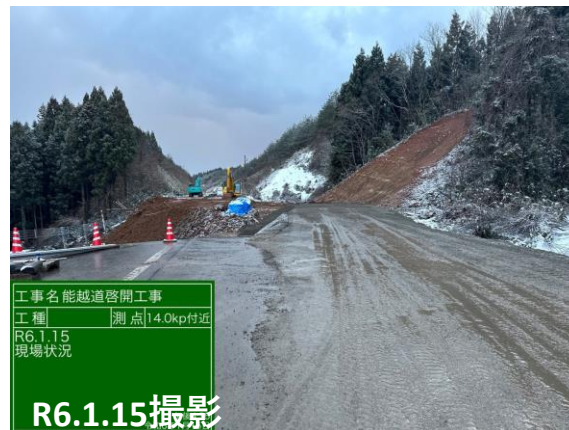
No.16 法面切土
