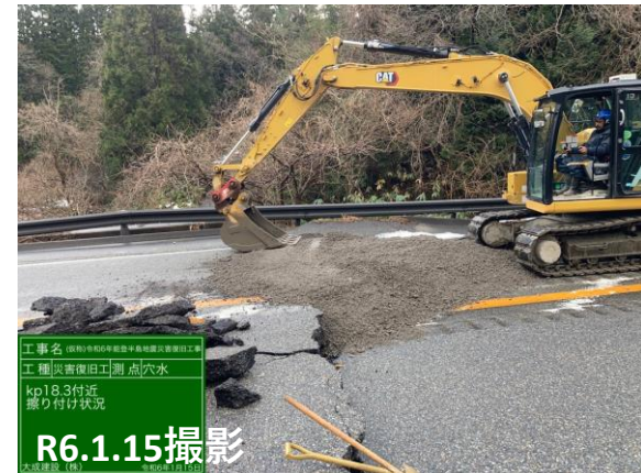
No.56 段差擦り付け
