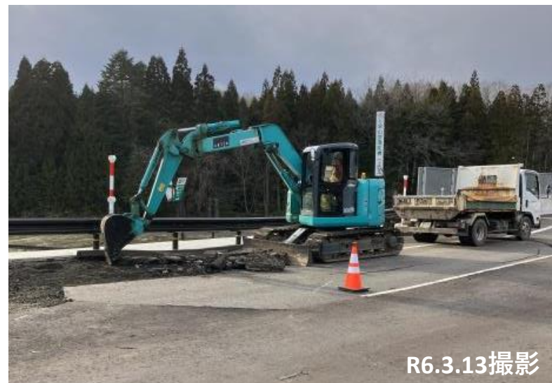
No.40付近 舗装撤去状況
