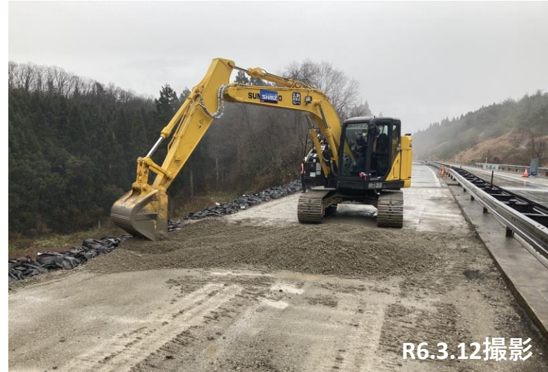
No.51付近 崩落箇所埋戻し状況
