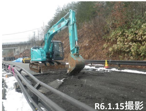
No.6段差復旧状況
