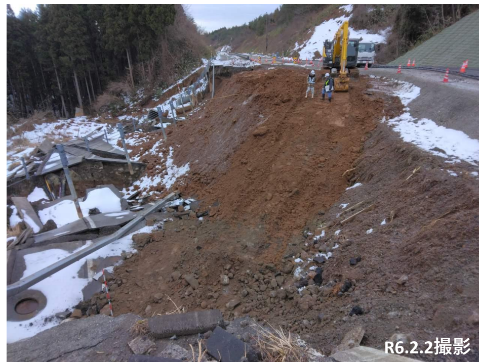
No.16 調査・整地状況
