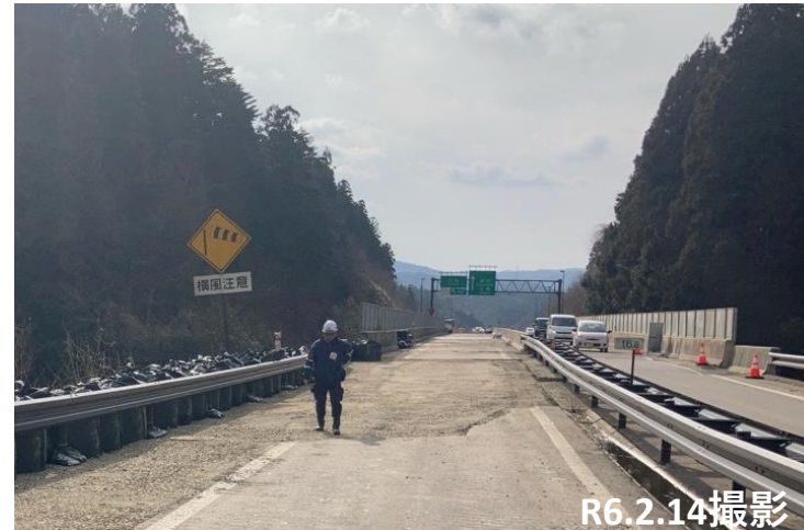
No.40 砕石敷均し状況
