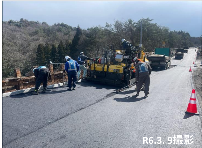
No. 45加熱合材施工状況
