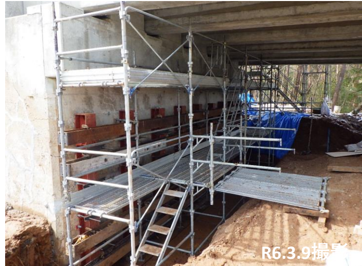
能登大橋 A1橋台足場組立状況
