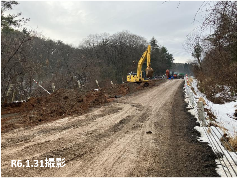
No.40路盤造成状況
