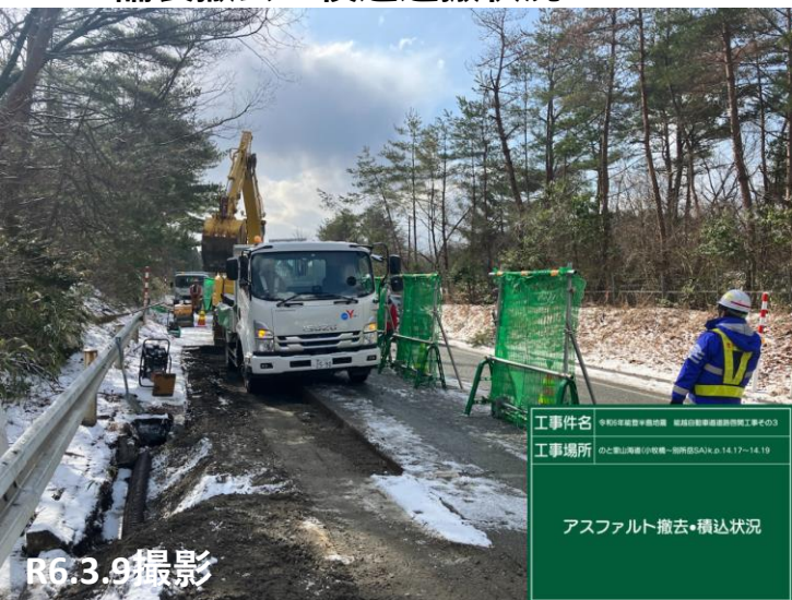
No.14 舗装撤去 積込運搬状況
