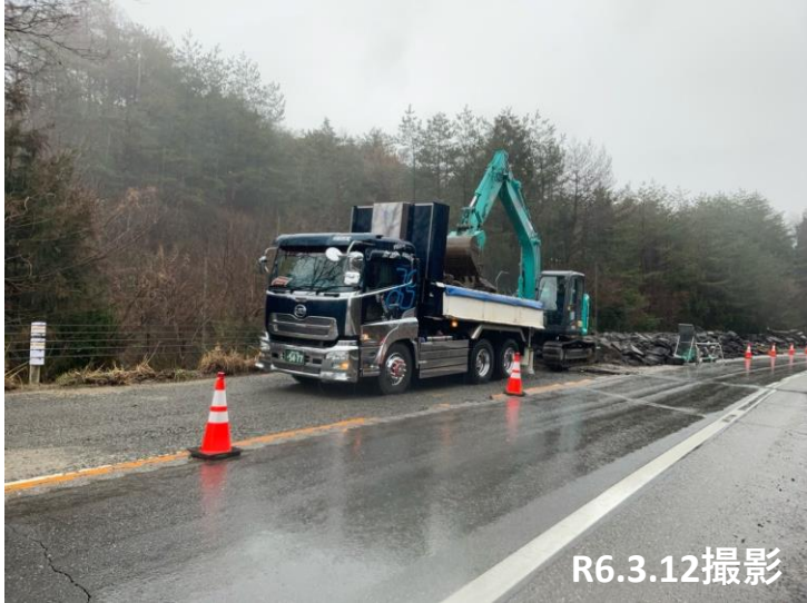
No.8 ガラ搬出状況
