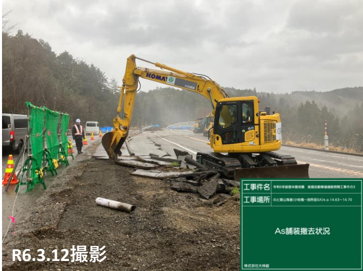
No.17 舗装撤去状況
