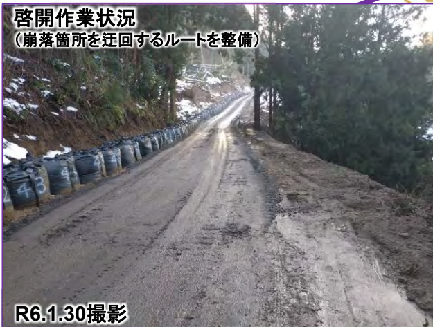
啓開作業状況 (崩落箇所を迂回するルートを整備)
