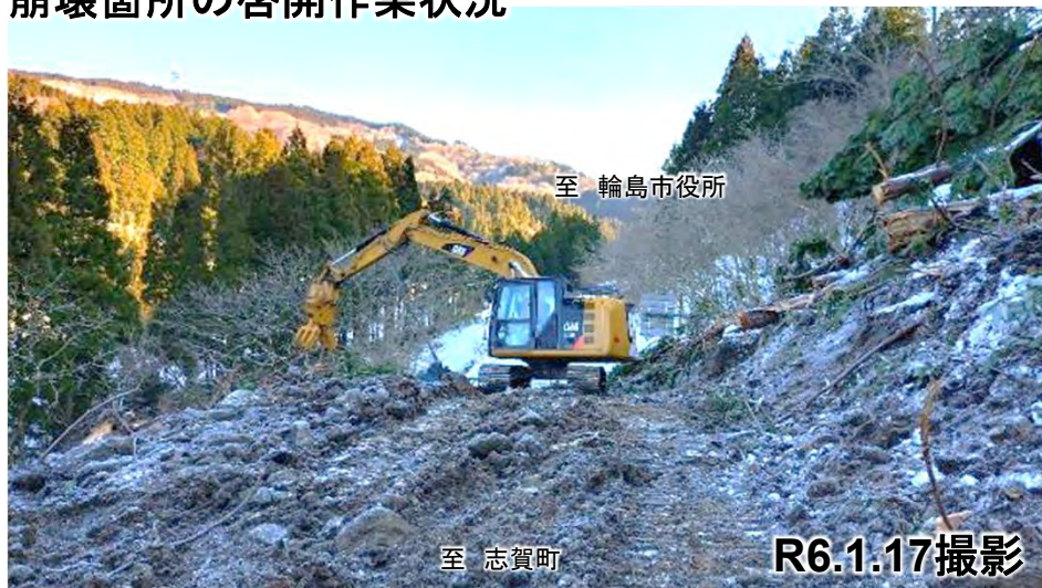
崩壊箇所の啓開作業状況
