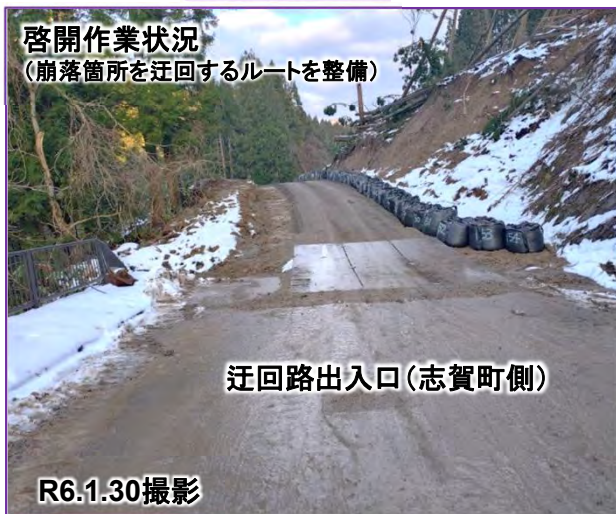
啓開作業状況 (崩落箇所を迂回するルートを整備)
