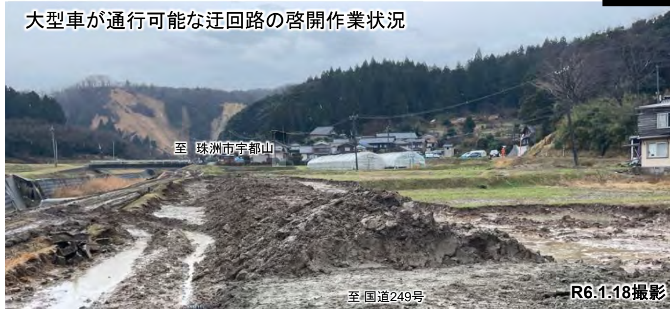
大型車が通行可能な迂回路を啓開作業状況
