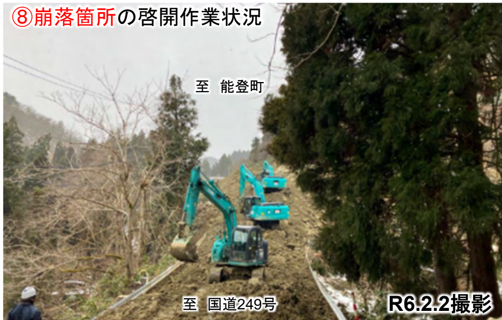
⑧崩落箇所の啓開作業状況
