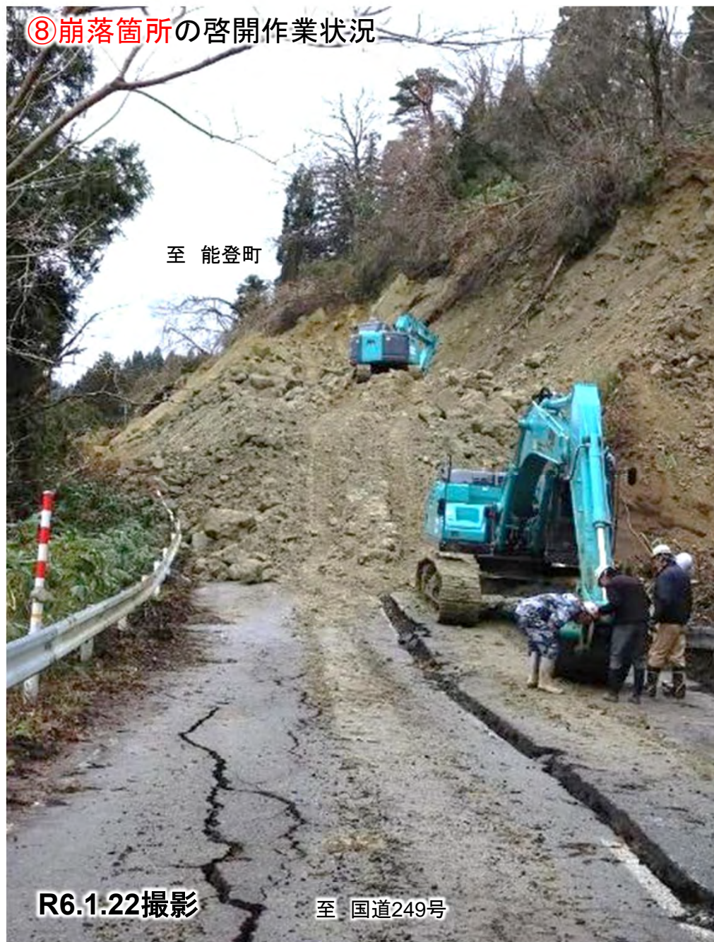
⑧崩落箇所の啓開作業状況
