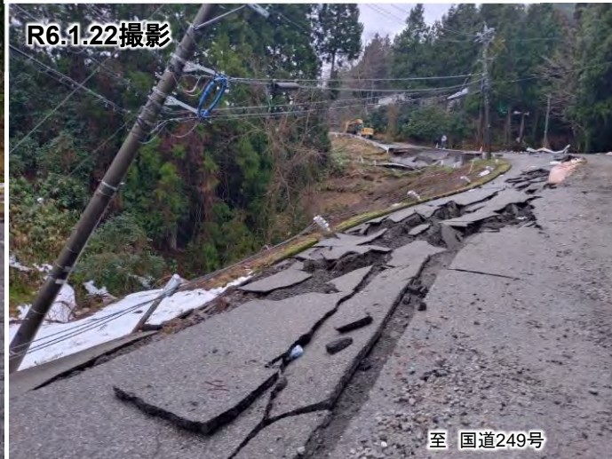
崩落箇所の被災状況、啓開作業状況
