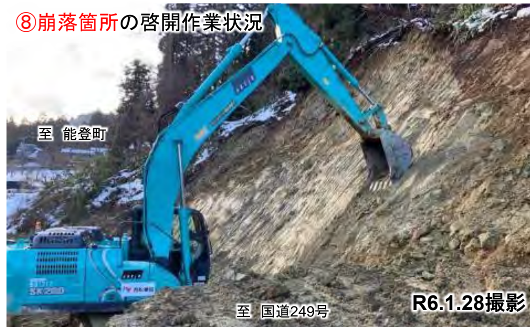
⑧崩落箇所の啓開作業状況
