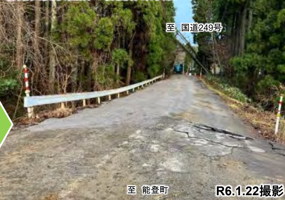
⑦路面変状箇所の啓開作業状況
