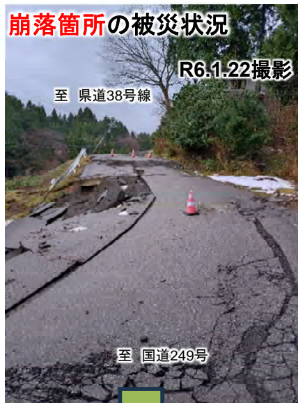
崩落箇所の被災状況、啓開作業状況
