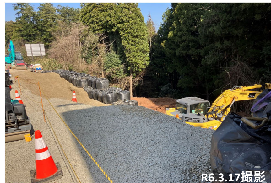
No.37大型土嚢設置、碎石投入状況
