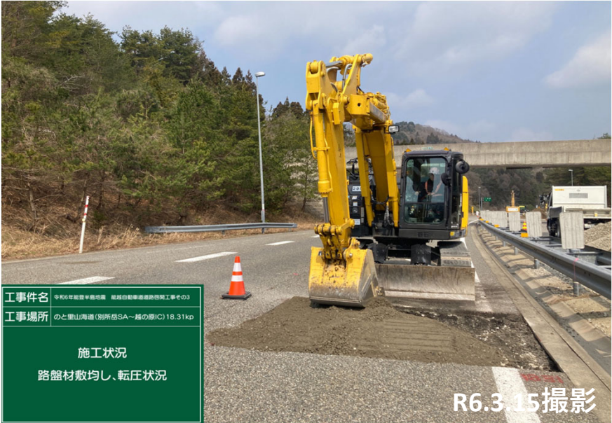
No.5路盤材敷均し、転圧状況
