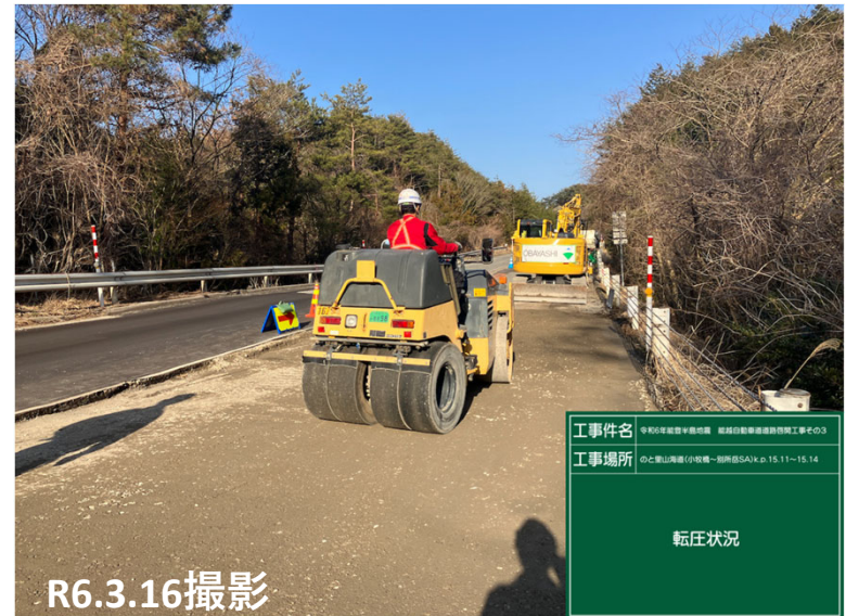
No.21 転圧状況
