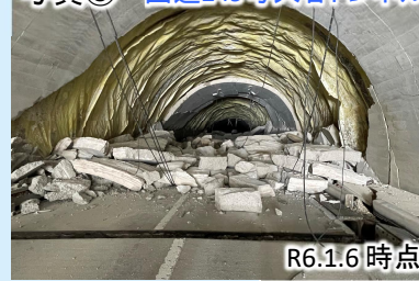
写真⑤ 国道249号大谷トンネル
