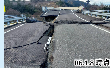
写真④ 国道249号鳥川橋
