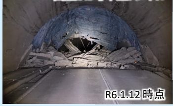
写真① 国道249号中屋トンネル
