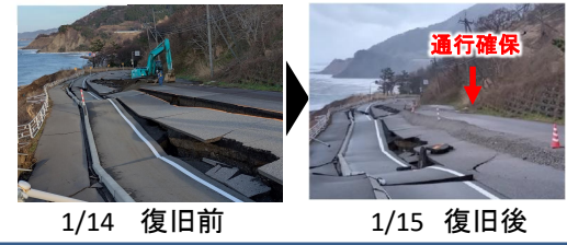
写真② 国道249号緊急復旧完了
