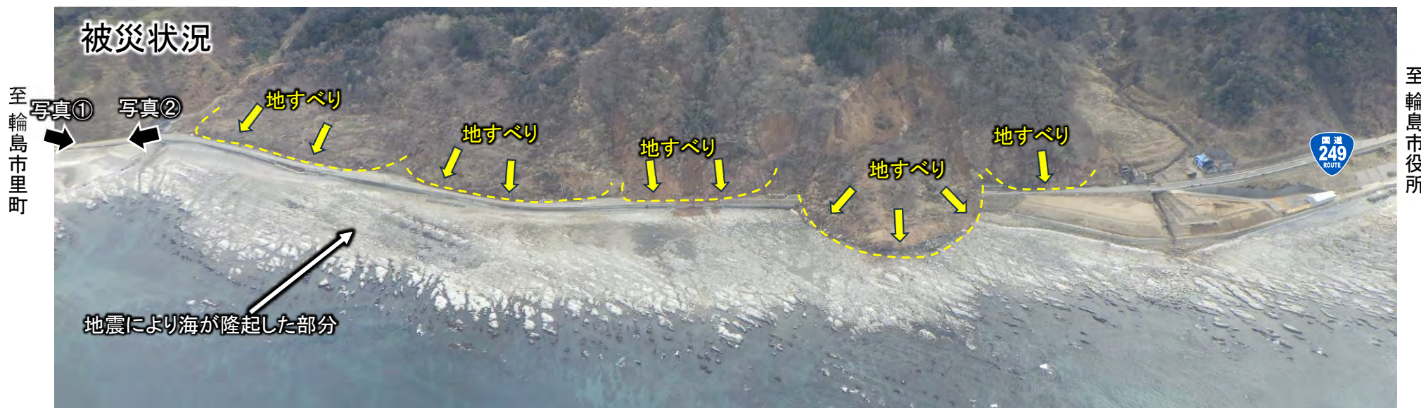
写真① 建設機械等の進入路を整備中
