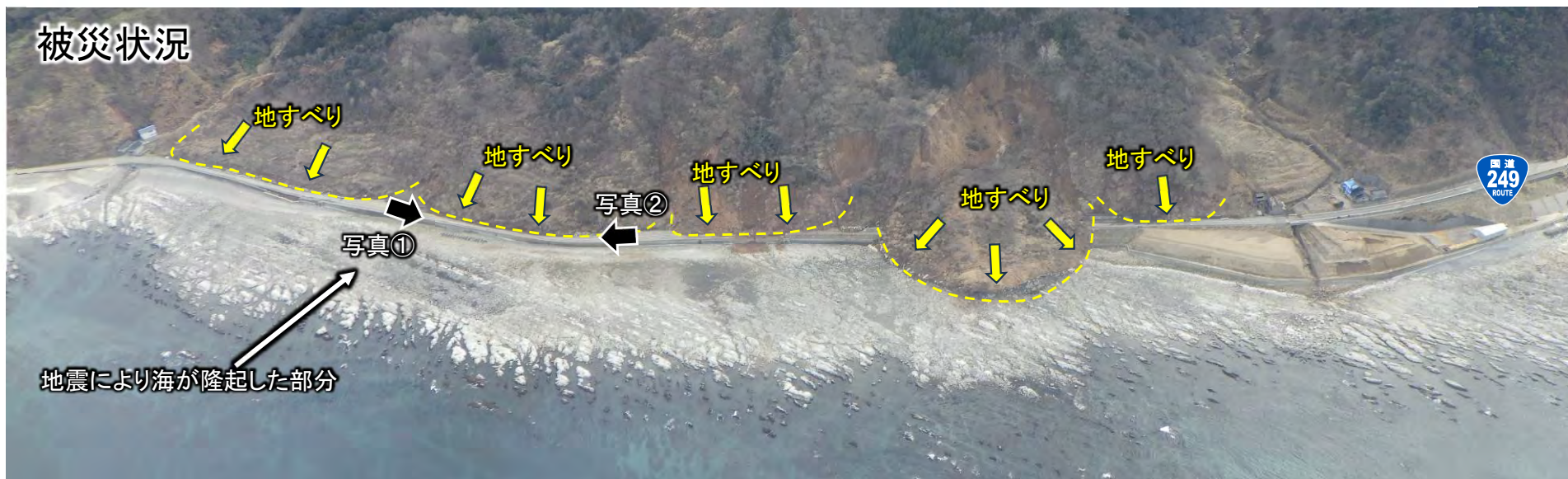
写真① 建設機械等進入路整備中
