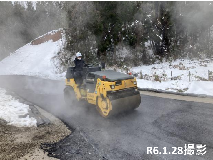
No17～29 舗装状況
