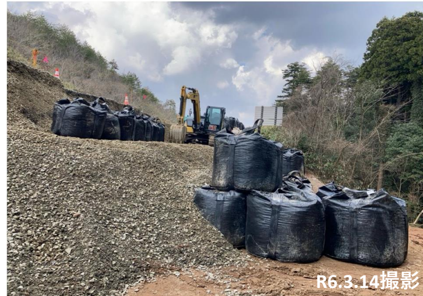
No.37 大型土のう設置・砕石投入状況
