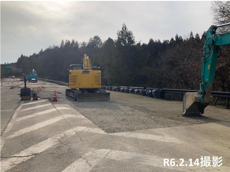
No.56 舗装撤去・砕石埋戻し
