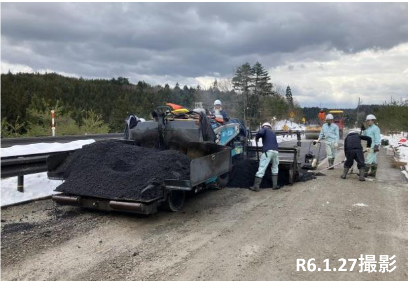
No17～29 舗装・段差復旧状況
