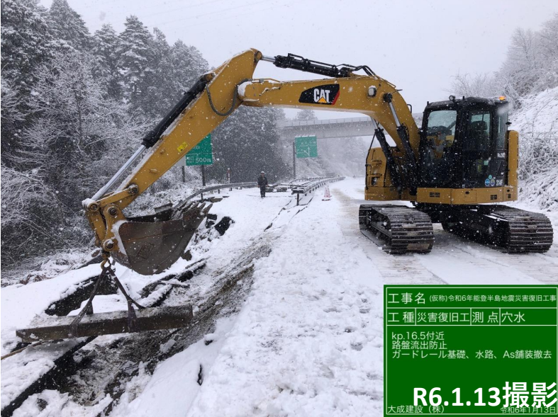
No.36 ガードレール撤去
