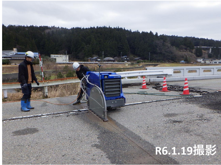
No.6 段差復旧状況
