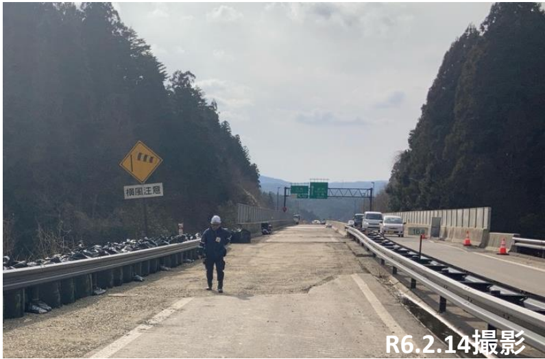
No.40 砕石敷均し状況
