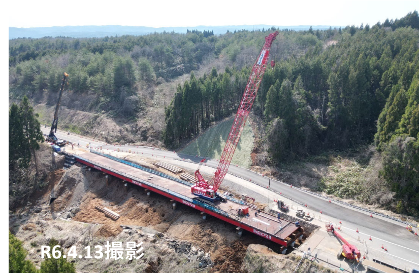
No.16付近 仮栈橋設置状況
