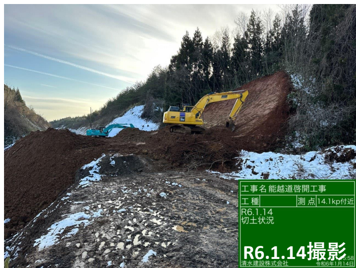
No.16 切土状況
