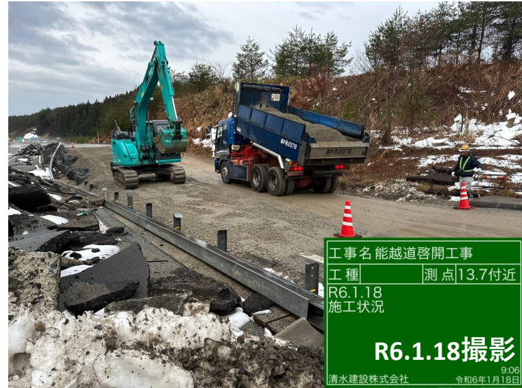
No.15 法面切土
