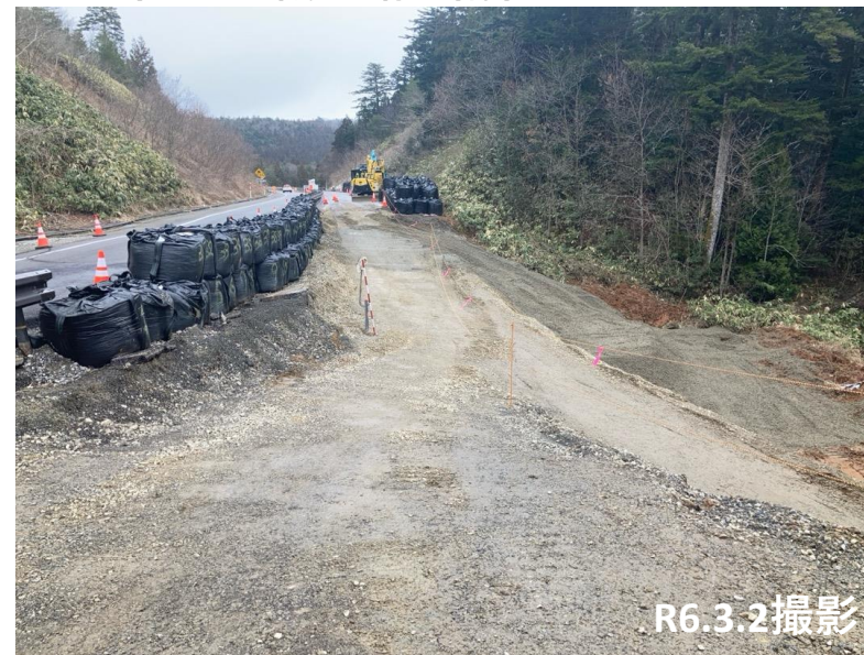
No.44付近 路盤不陸整正転圧状況
