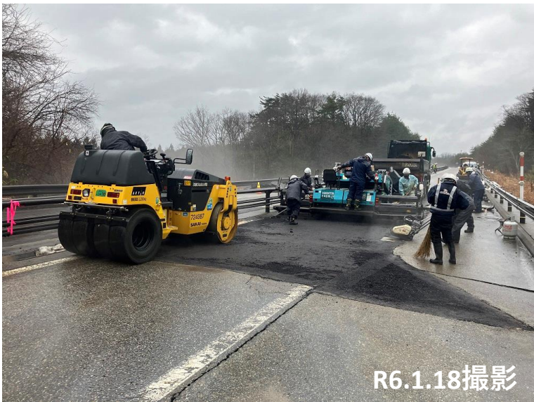
No.6 段差復旧状況
