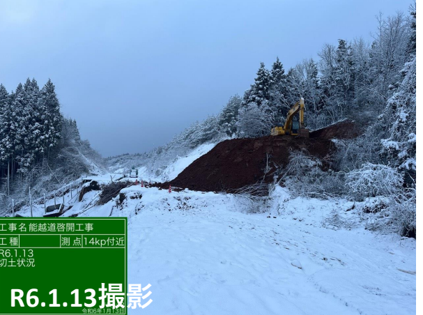
No.16 切土状況
