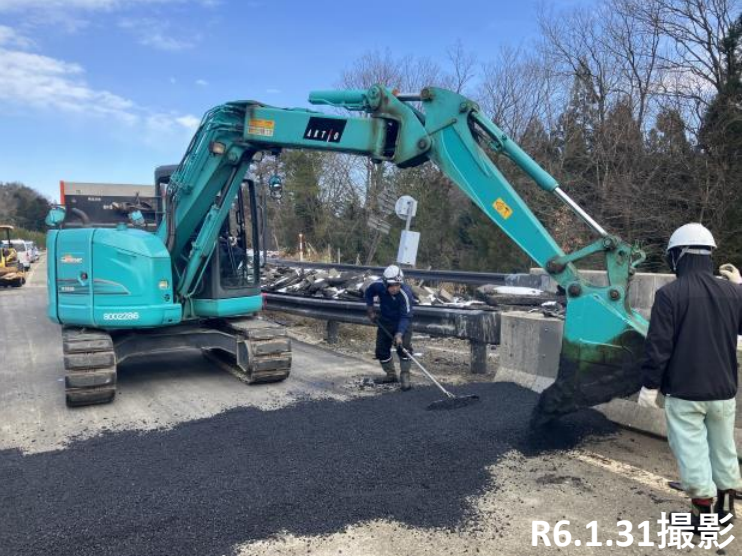
No32 舗装状況
