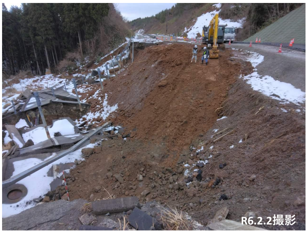
No.16 調査・整地状況
