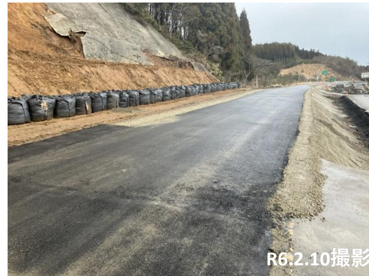
No.29 路盤整備およびAs舗装完了
