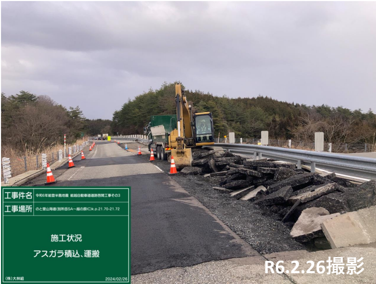
No.34付近 アスガラ積込・運搬状況
