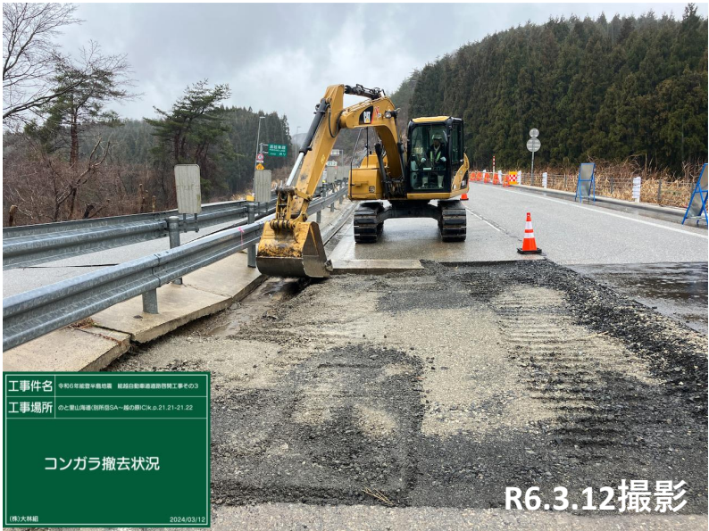
No.30付近 舗装撤去状況
