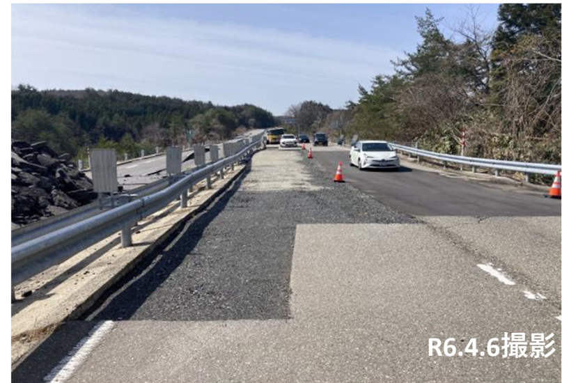
No.37付近 路盤完了状況
