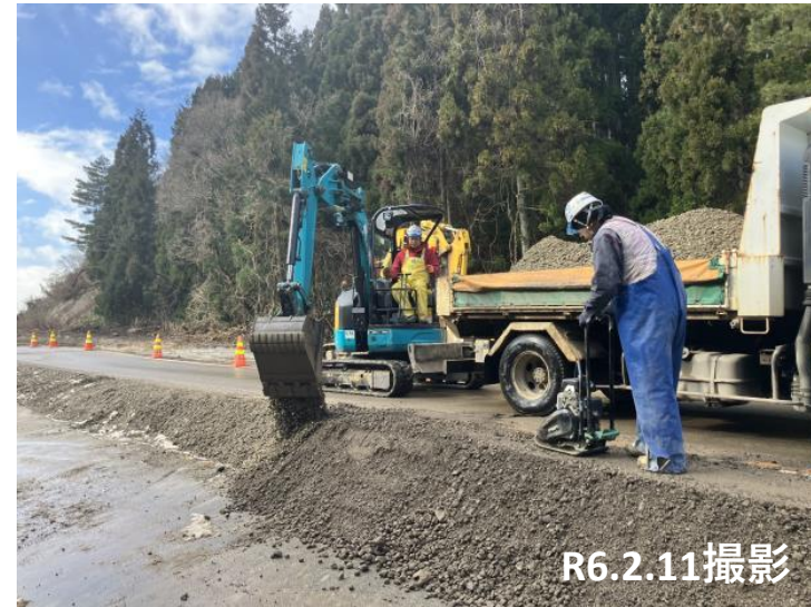
No.24付近 路肩路盤整備状況
