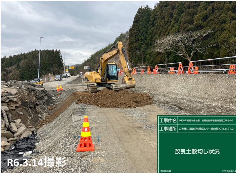
No.29 改良土敷き均し状況
