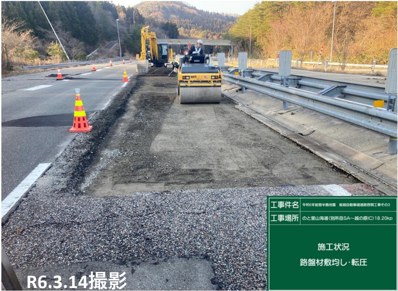
No.1 路盤材敷均し状況
