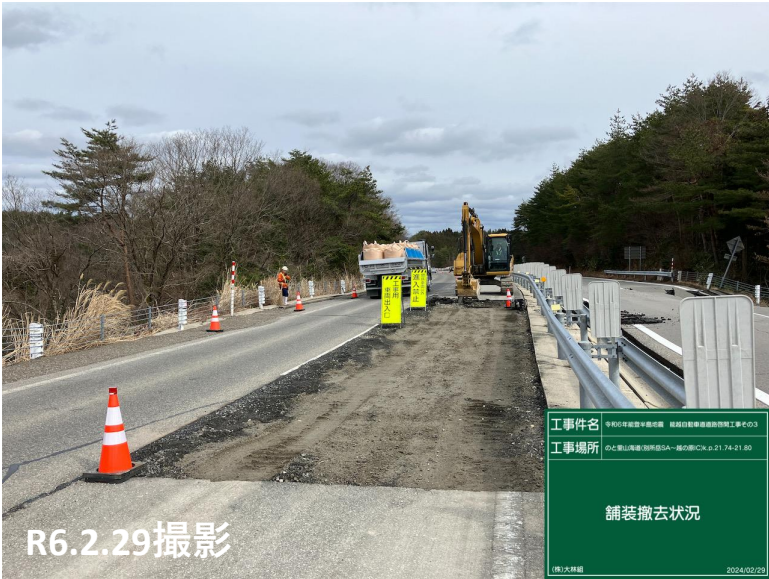
No.35付近 舗装撤去状況
