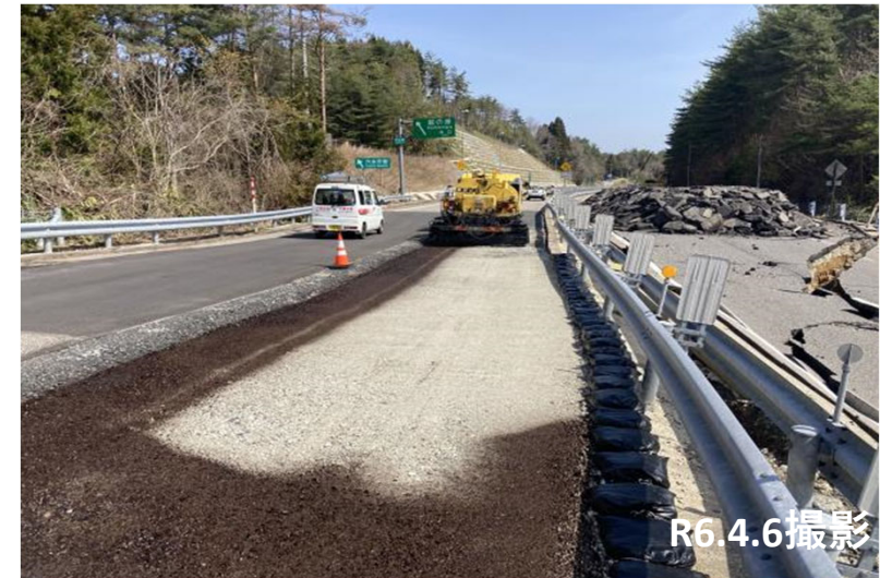
No.37付近 路盤完了状況
