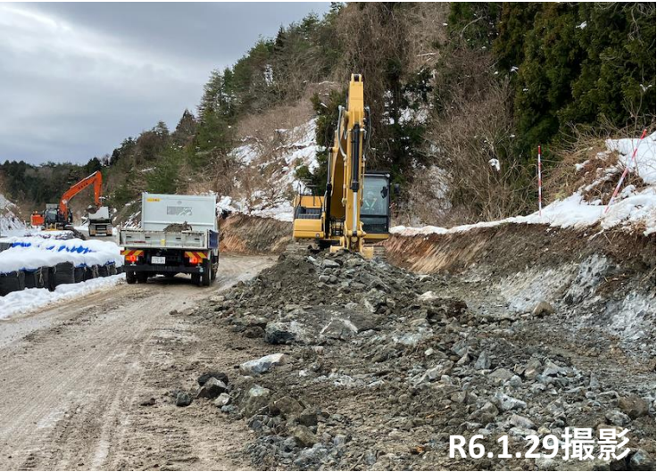
No.7～30土砂撤去状況
