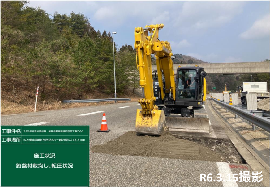
No.5路盤材敷均し、転圧状況
