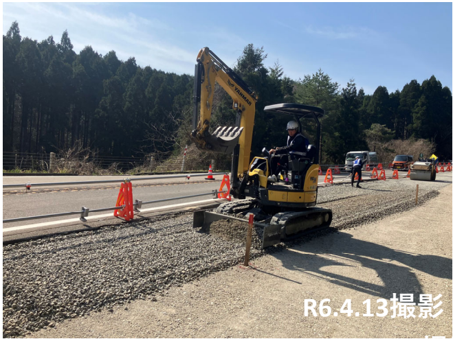
No.24付近 路盤工状況
