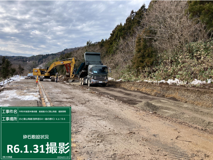
No.16 砕石敷設状況
