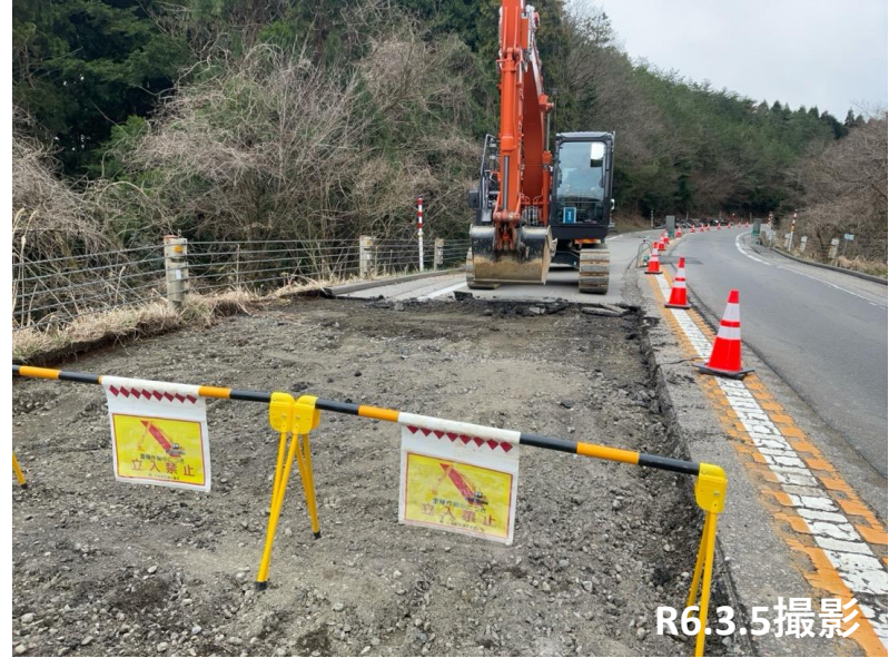
No.8 砕石転圧状況
