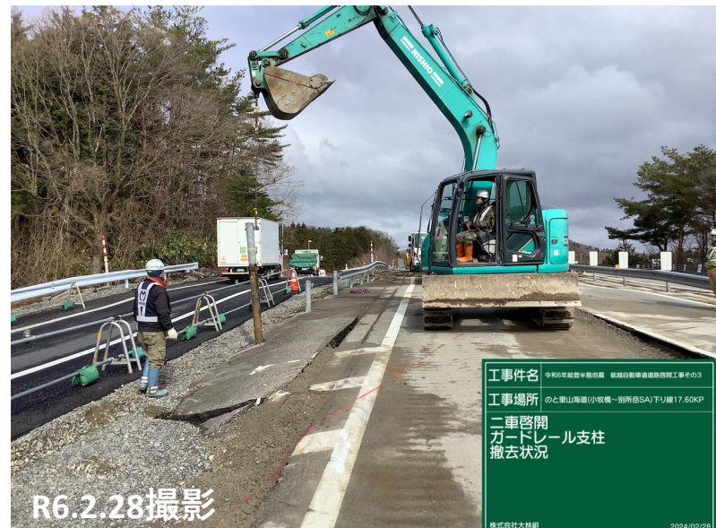
No.44 ガードレール支柱撤去状況
