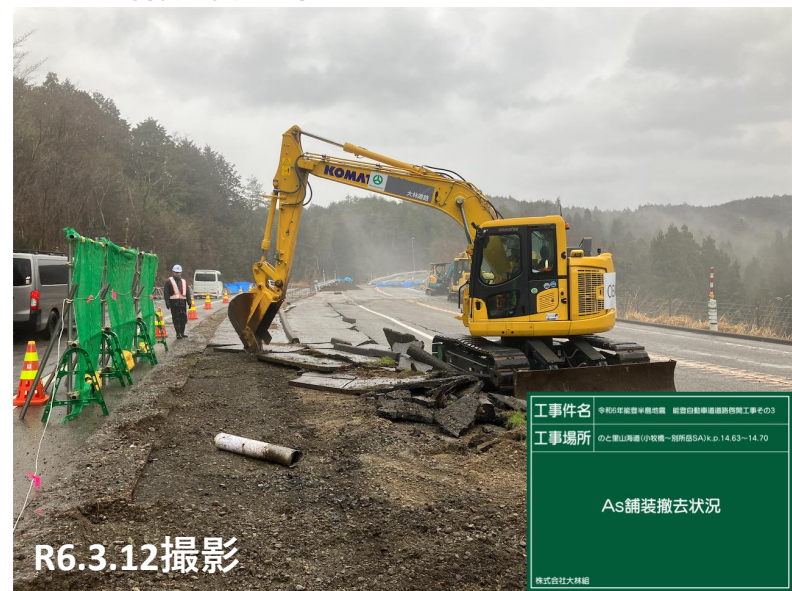
No.17 舗装撤去状況
