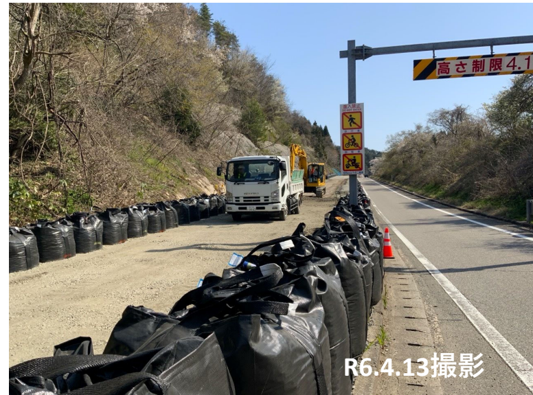
No.1付近 碎石敷均し状況
