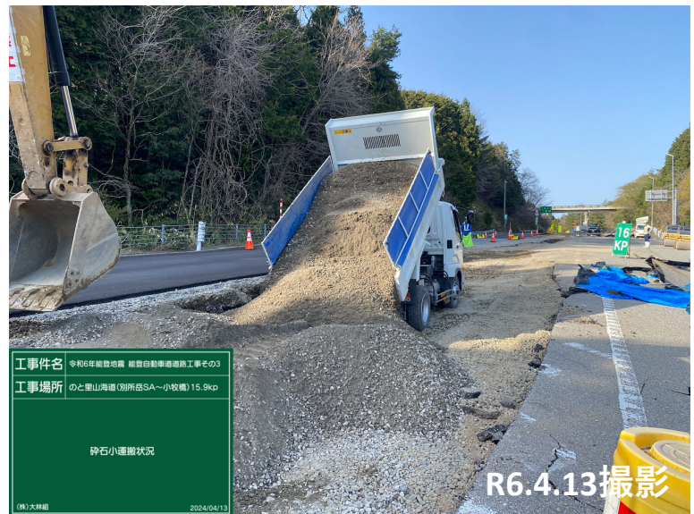
No.25付近 碎石小運搬状況
