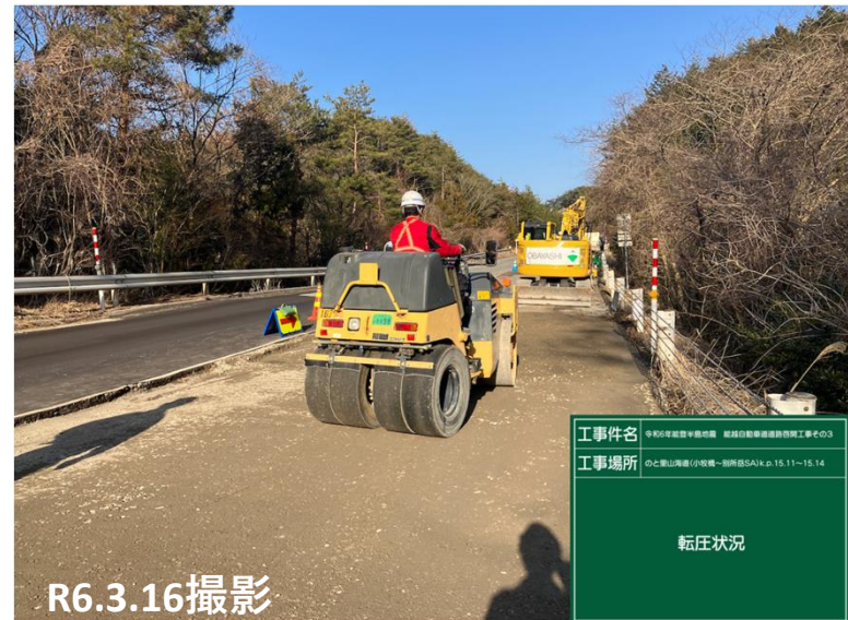
No.21 転圧状況
