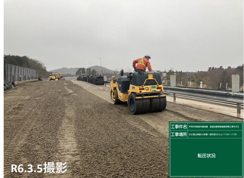
No.44 転圧状況
