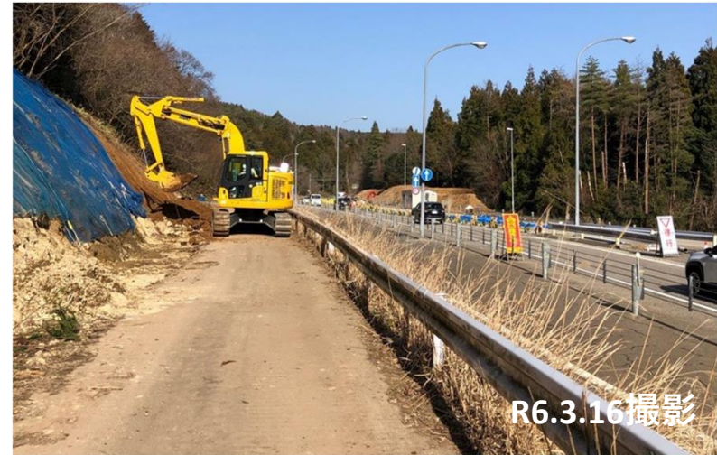
No.1付近 伐採作業状況
