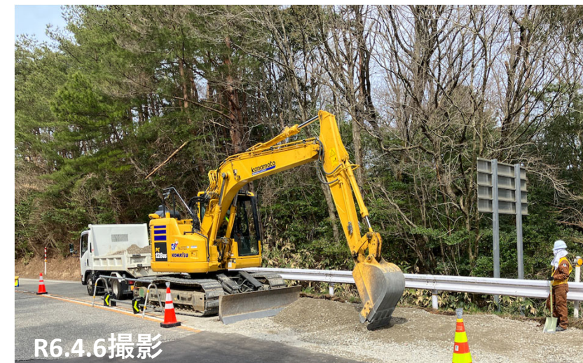
No.11 砕石敷均し状況
