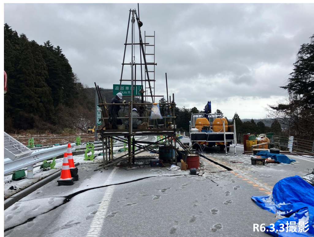
No.18 ボーリング調査状況
