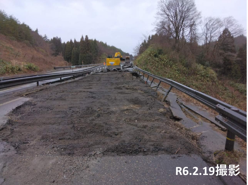
No.28付近 舗装撤去・砕石埋戻し状況
