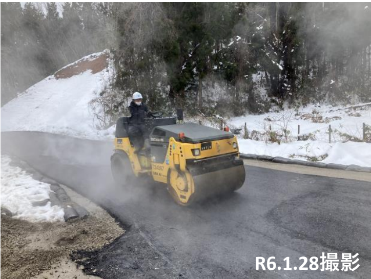
No17～29 舗装状況
