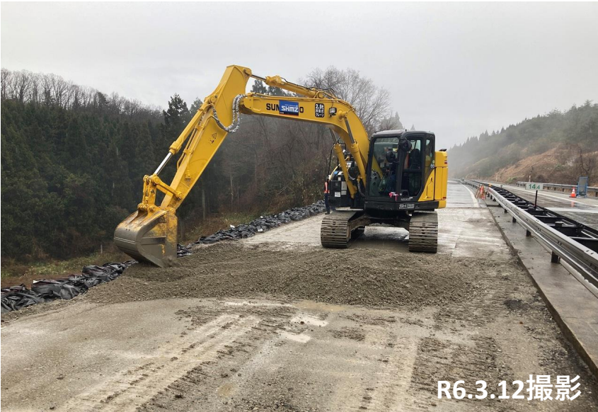
No.51付近 崩落箇所埋戻し状況
