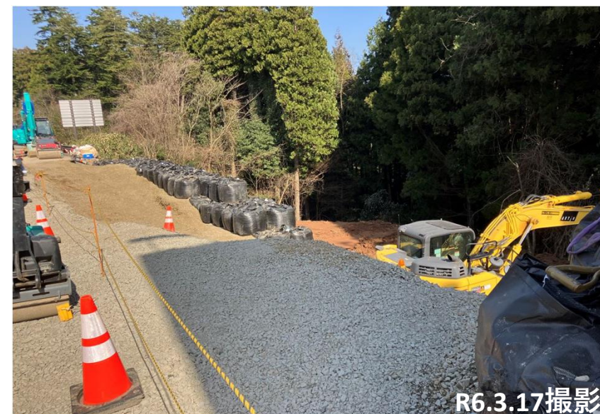
No.37大型土嚢設置、碎石投入状況
