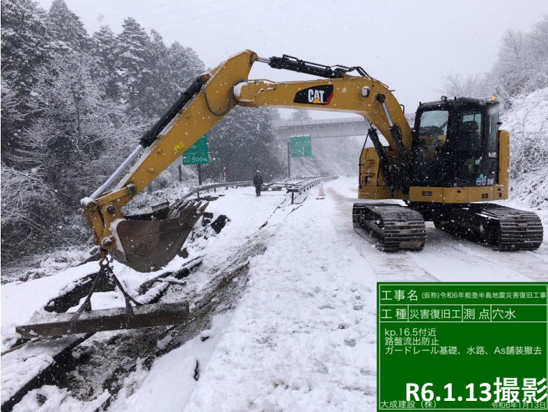
No.36 ガードレール撤去
