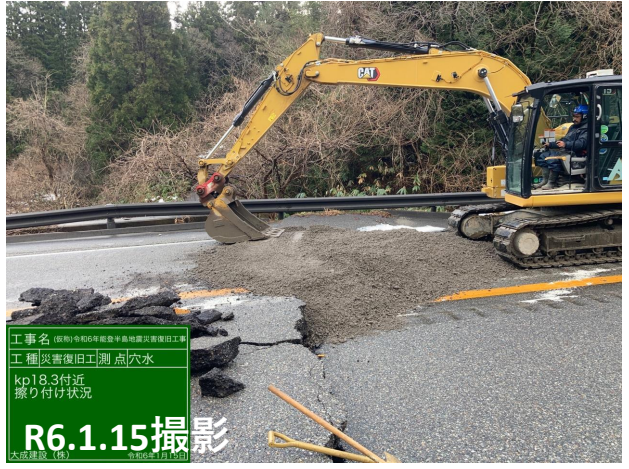
No.56 段差擦り付け
