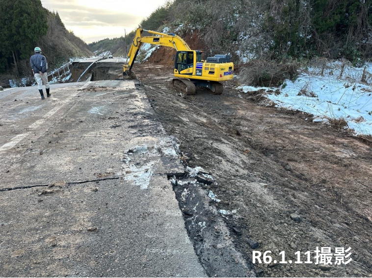
No.16 碎石充填状況
