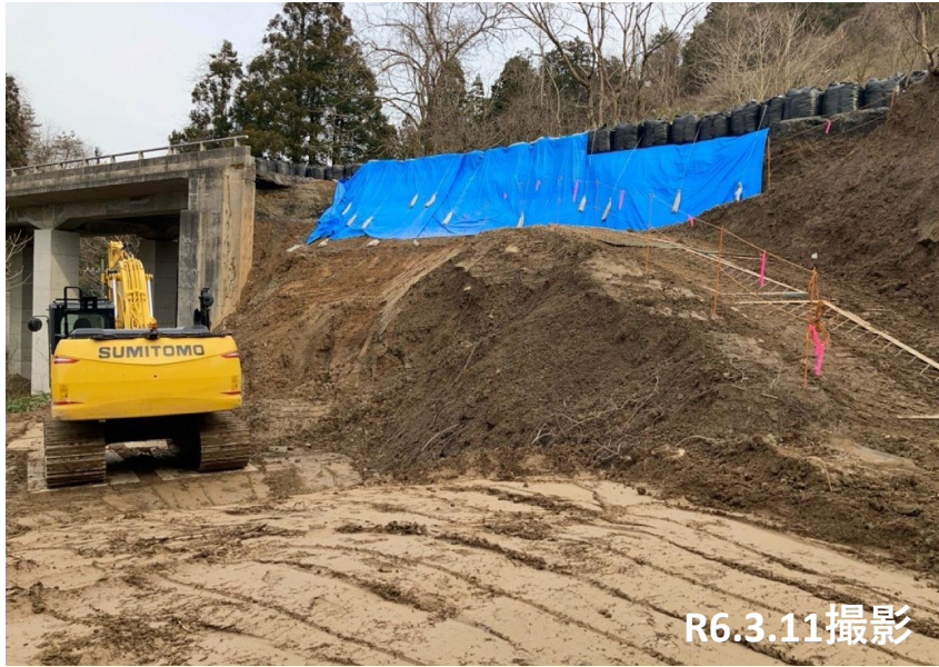
No.51付近 崩落箇所埋戻し状況
