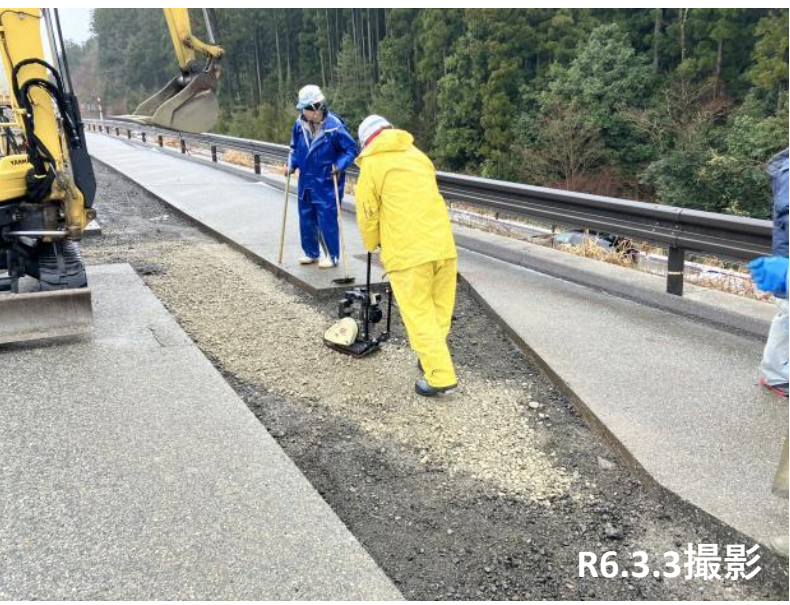
No.44付近 路盤不陸整正転圧状況
