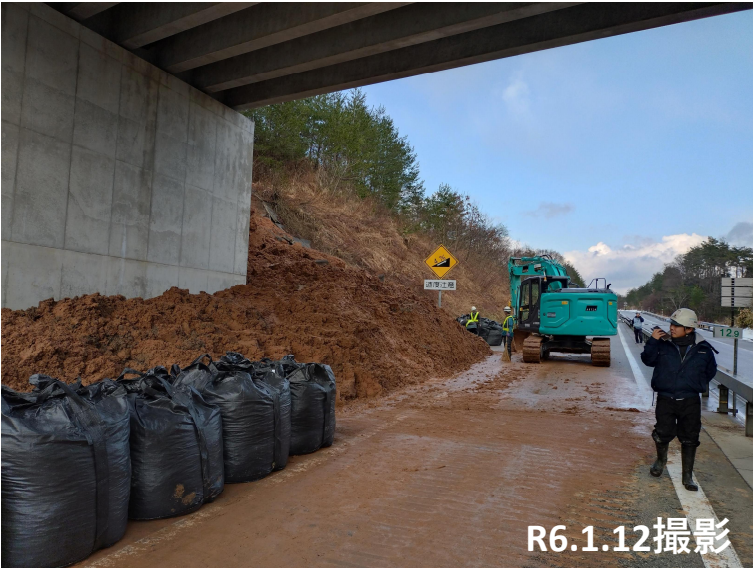
No.6 掘削・土嚢設置状況
