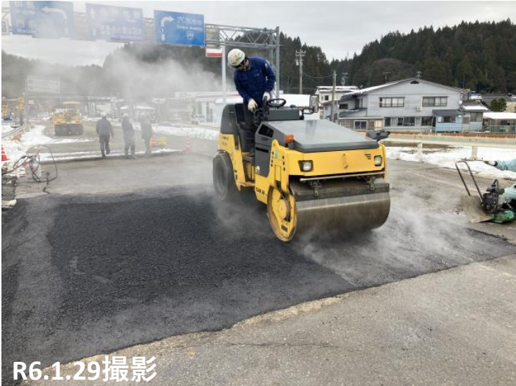
No41～42 舗装状況
