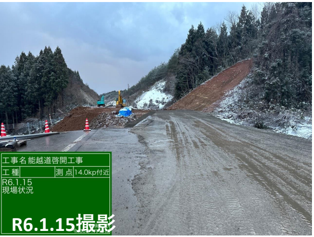
No.16 法面切土
