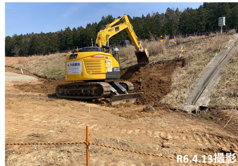
No.44付近 法面切土掘削状況
