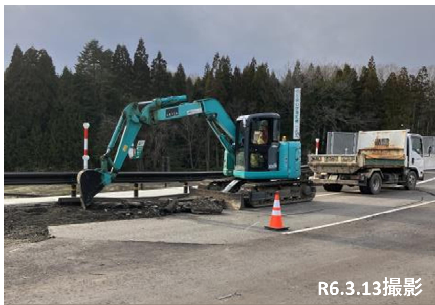
No.40付近 舗装撤去状況
