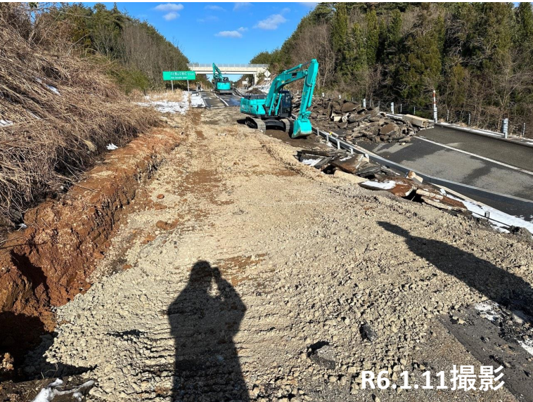
No.15 碎石充填状況
