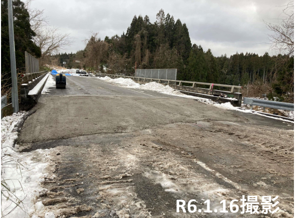
No.51 段差擦り付け
