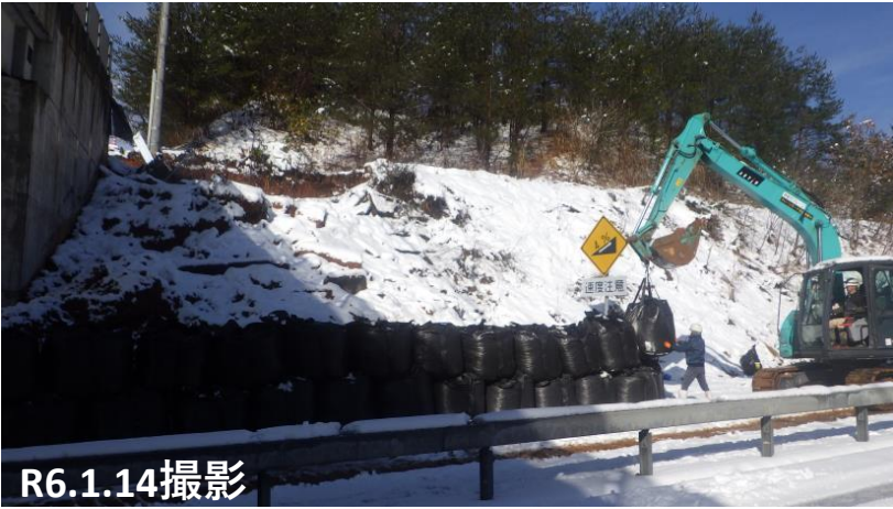
No.6 土嚢設置
