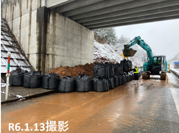
No.6 土嚢設置
