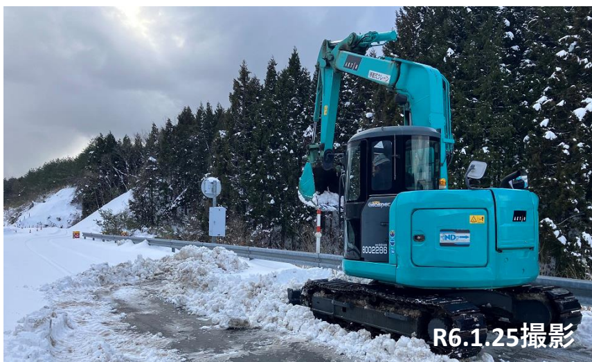
復旧箇所の除雪状況
