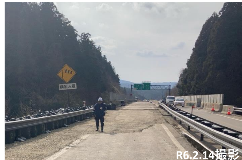
No.40 砕石敷均し状況
