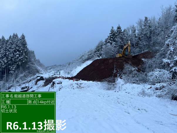
No.16 切土状況
