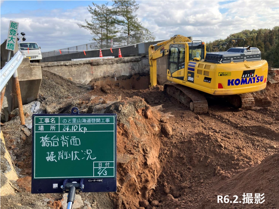
No. 50 橋台背面掘削状況
