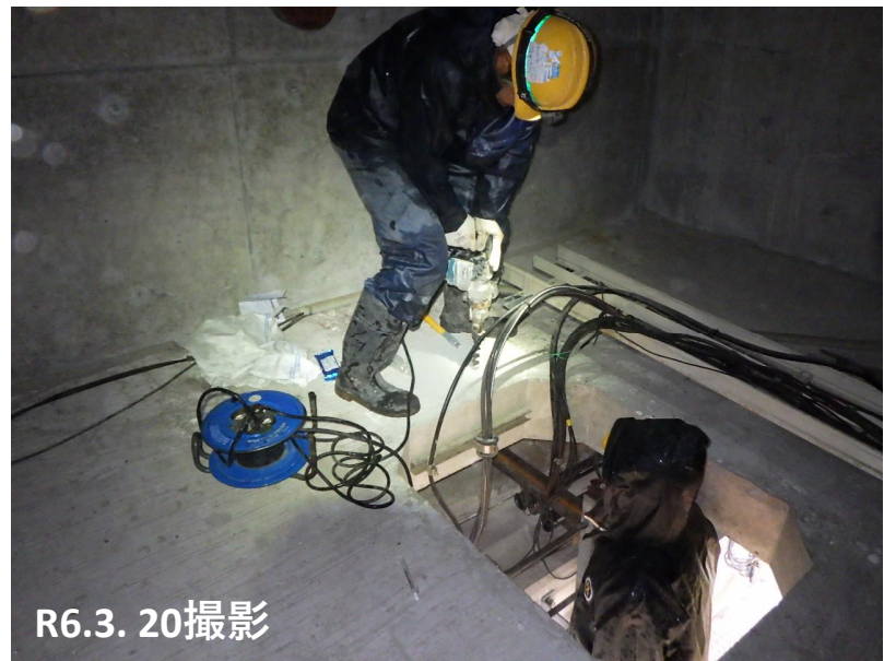
能登大橋 箱桁出入り口手掛け設置状況
