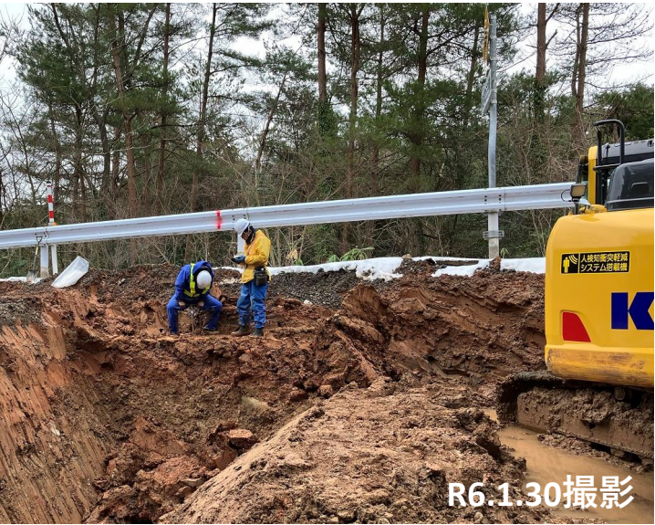
No.48詳細調査状況
