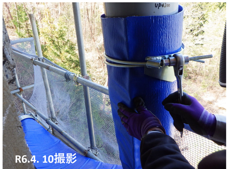
能登大橋・PA2橋台 排水管取替え状況
