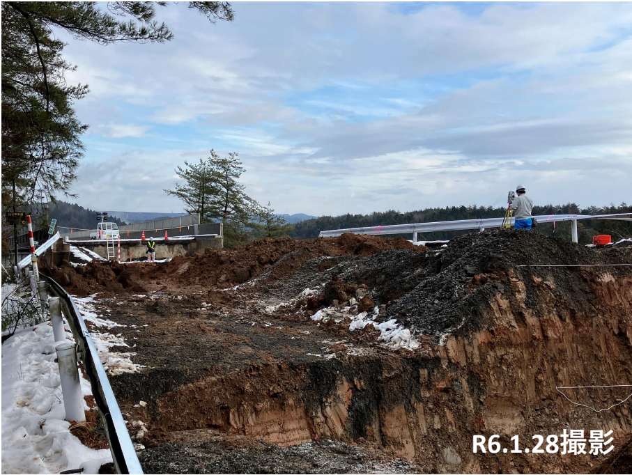
No.48測量状況
