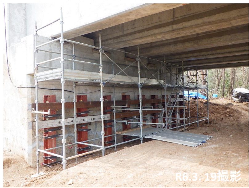
能登大橋 箱桁出入り口手掛け設置状況
