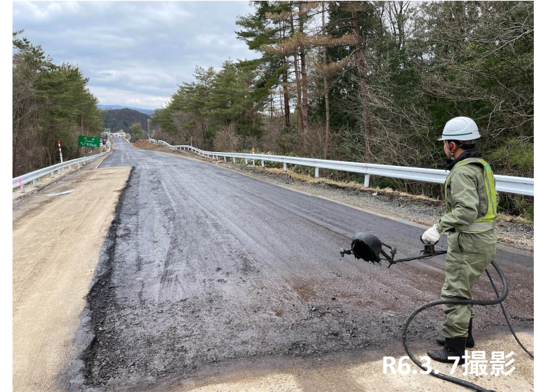
No. 45 舗装工乳剤散布施工状況
