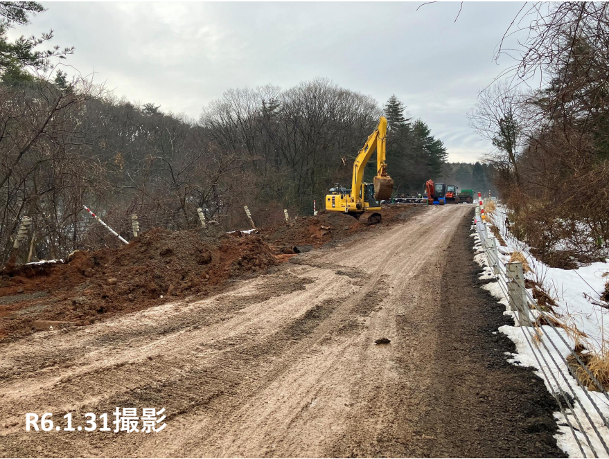
No.40路盤造成状況
