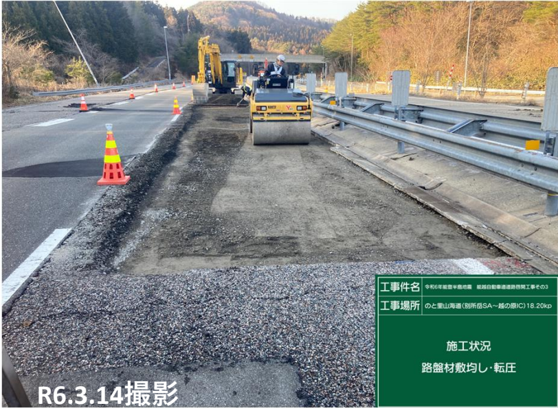
No.1 路盤材敷均し状況
