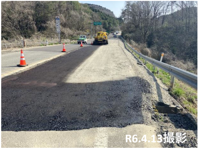
No.13付近 乳剤散布状況
