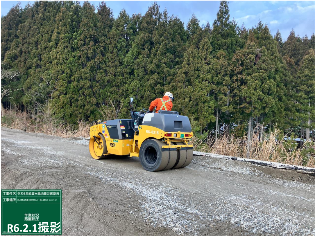
No.30路盤転圧状況
