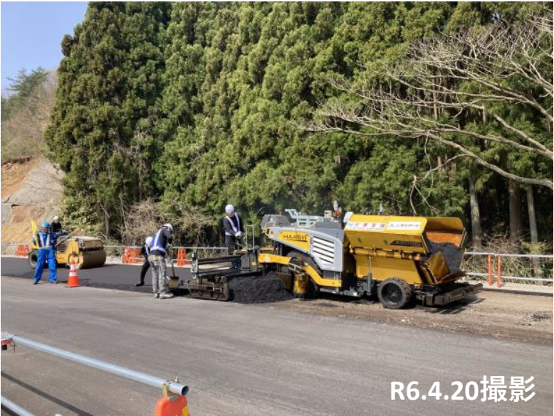
No.29付近 舗装状況
