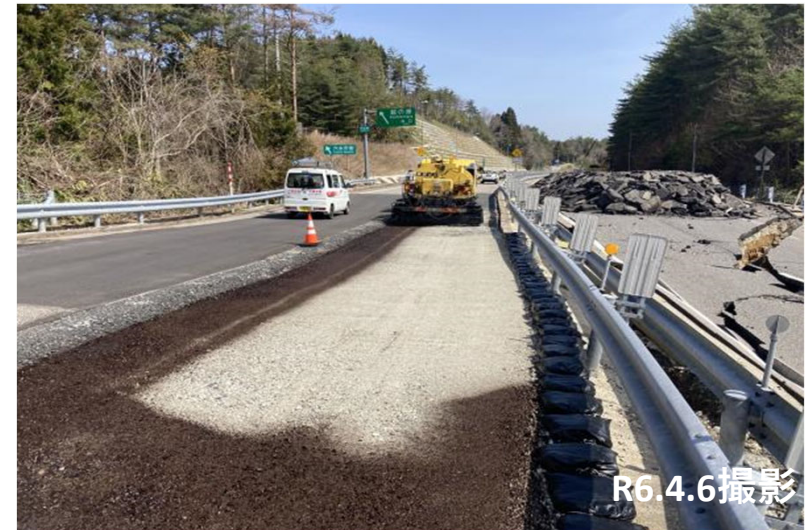
No.37付近 路盤完了状況
