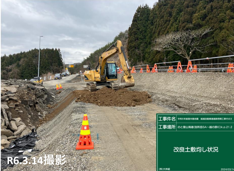
No.29 改良土敷き均し状況
