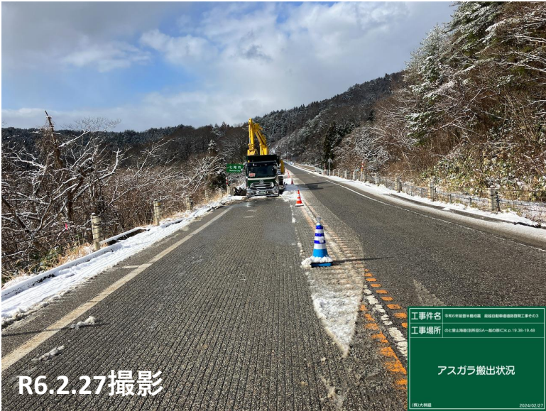
No.34付近 アスガラ積込・運搬状況
