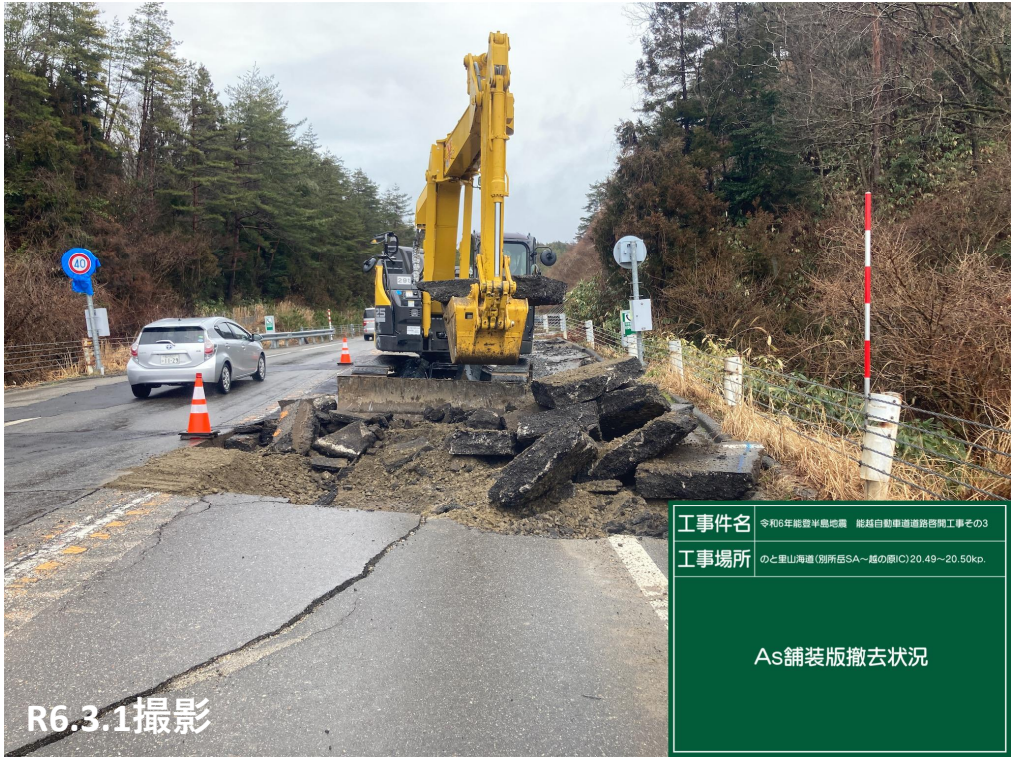
No.26付近 舗装撤去状況
