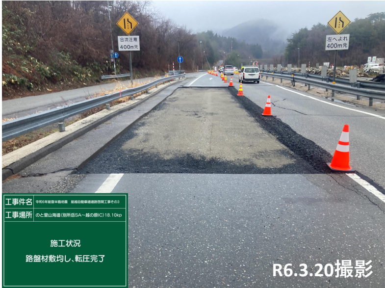
No.1 砕石敷均し・転圧状況
