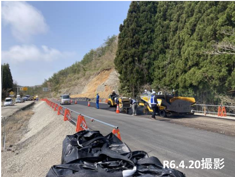
No.29付近 舗装状況
