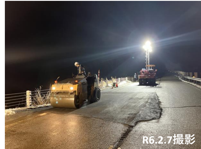
No.34付近 舗装状況
