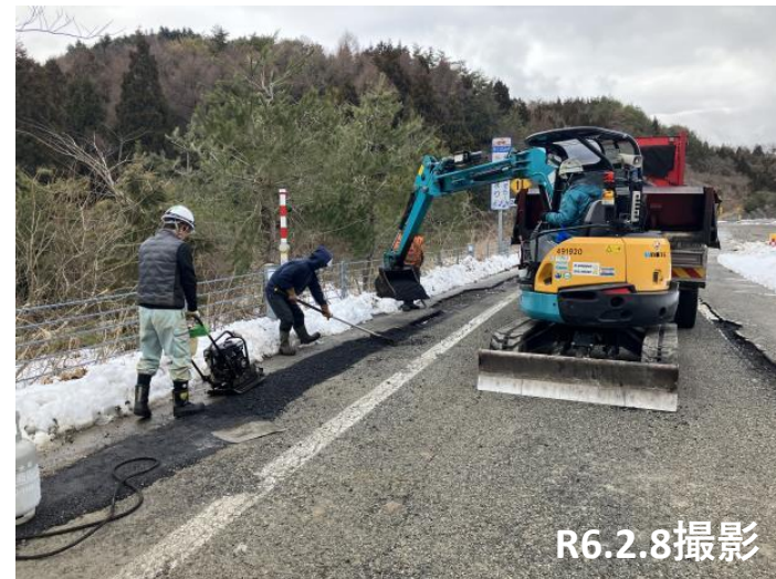
No.4付近 亀裂・段差補修状況
