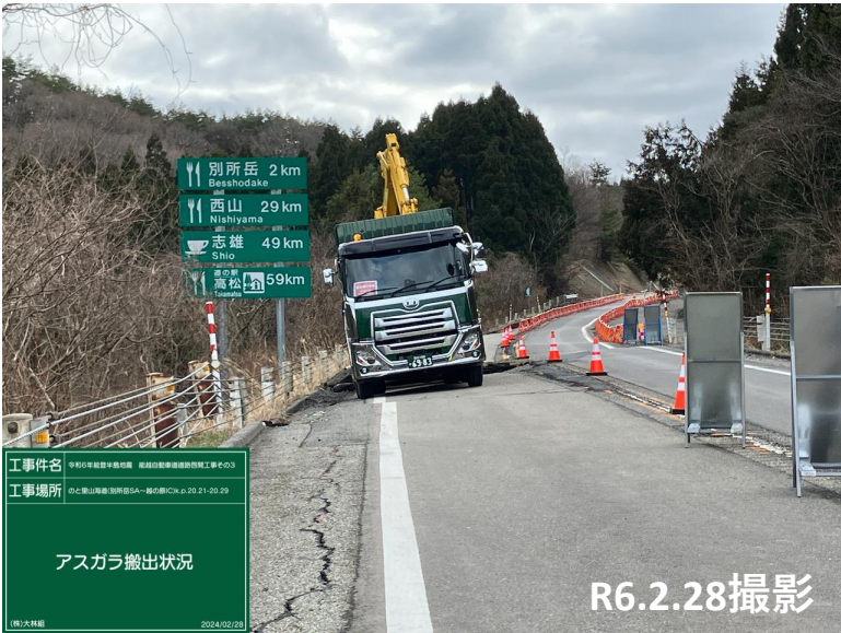
No.35付近 舗装撤去状況
