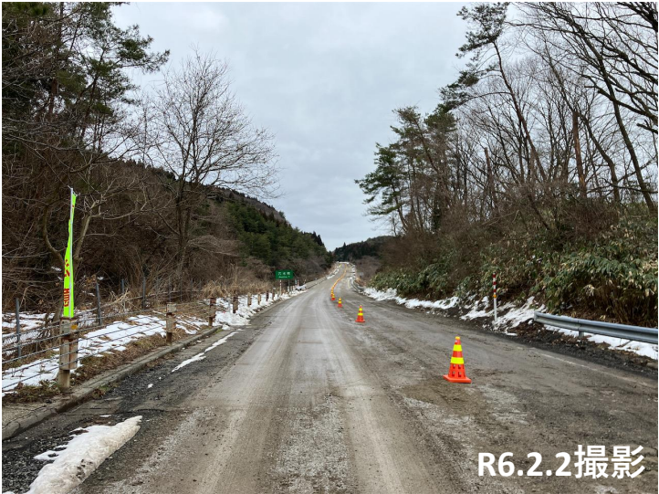
No.7付近 路盤施工状況
