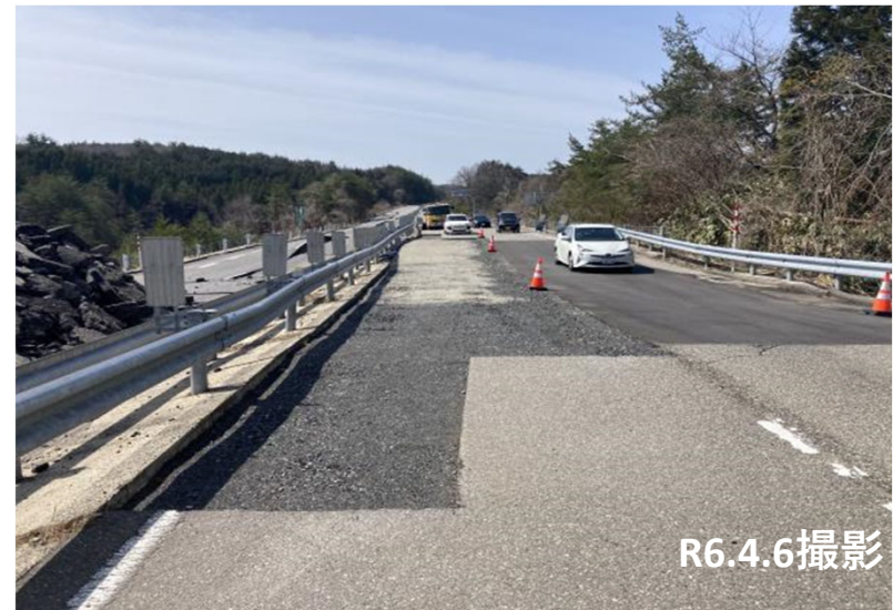
No.37付近 路盤完了状況
