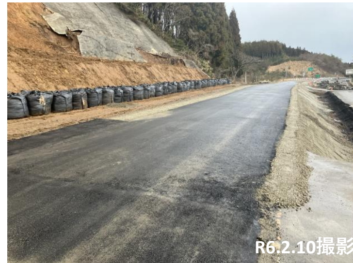
No.29 路盤整備およびAs舗装完了
