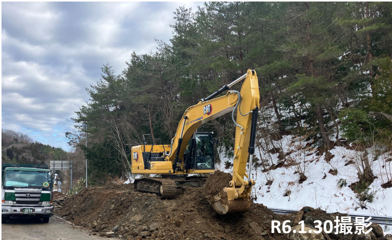
No.16掘削状況
