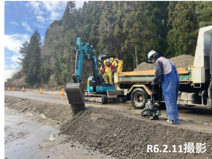
No.24付近 路肩路盤整備状況
