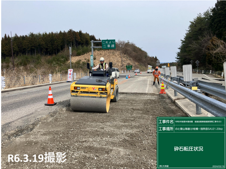
No.30 砕石敷均し・転圧状況
