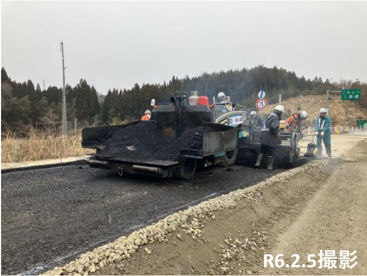
No.29～30付近 舗装施工状況
