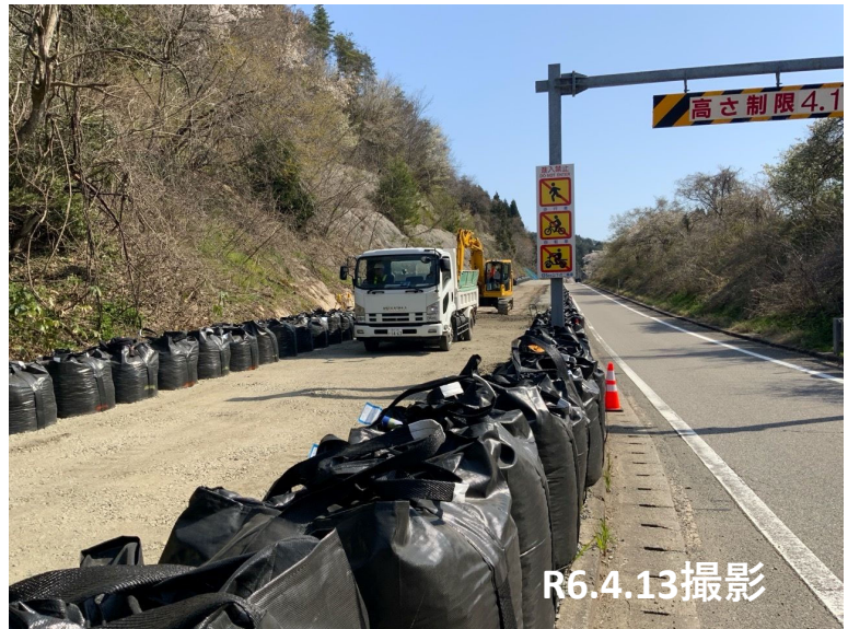
No.1付近 碎石敷均し状況
