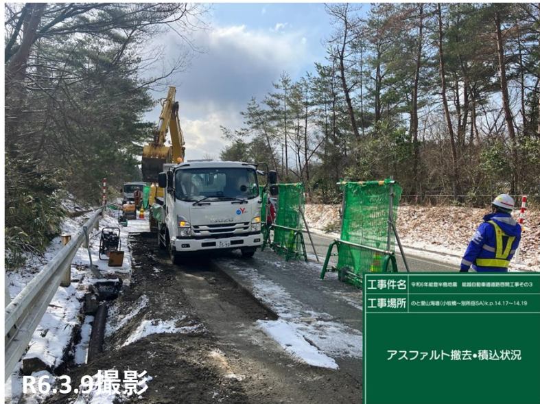
No.14 舗装撤去 積込運搬状況
