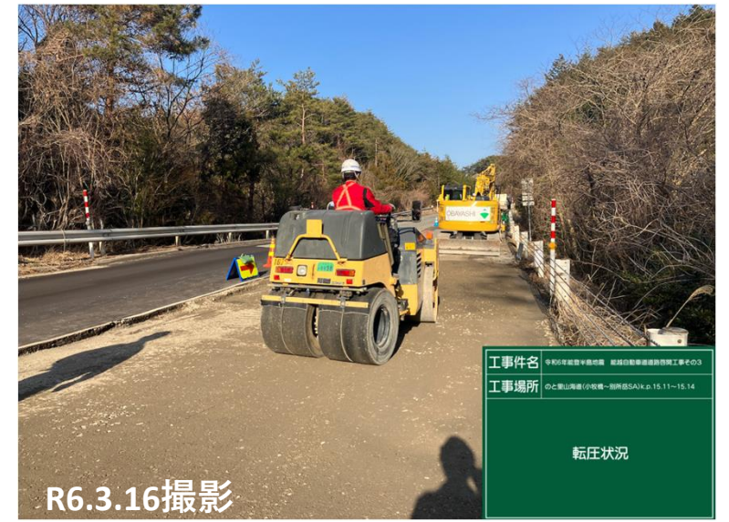
No.21 転圧状況
