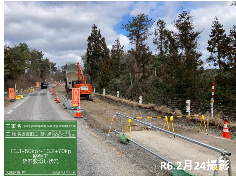
No.44 舗装撤去・碎石敷均し状況
