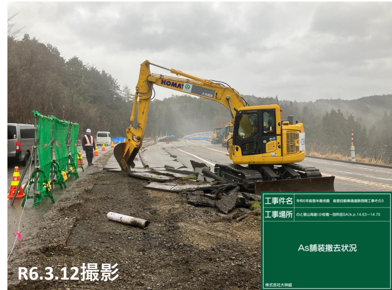
No.17 舗装撤去状況
