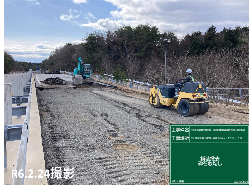
No.44 舗装撤去・碎石敷均し状況
