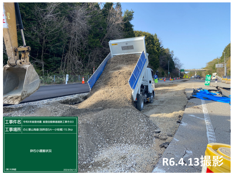
No.25付近 碎石小運搬状況
