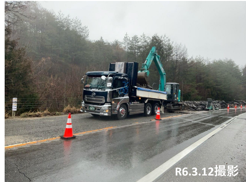
No.8 ガラ搬出状況
