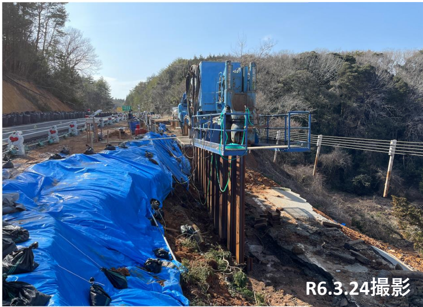
No. 5 鋼矢板圧入状況
