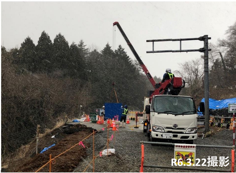
No.33 交通標識撤去状況
