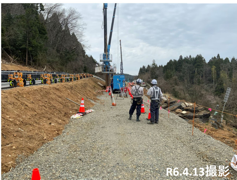
No.33付近 鋼矢板打設状況
