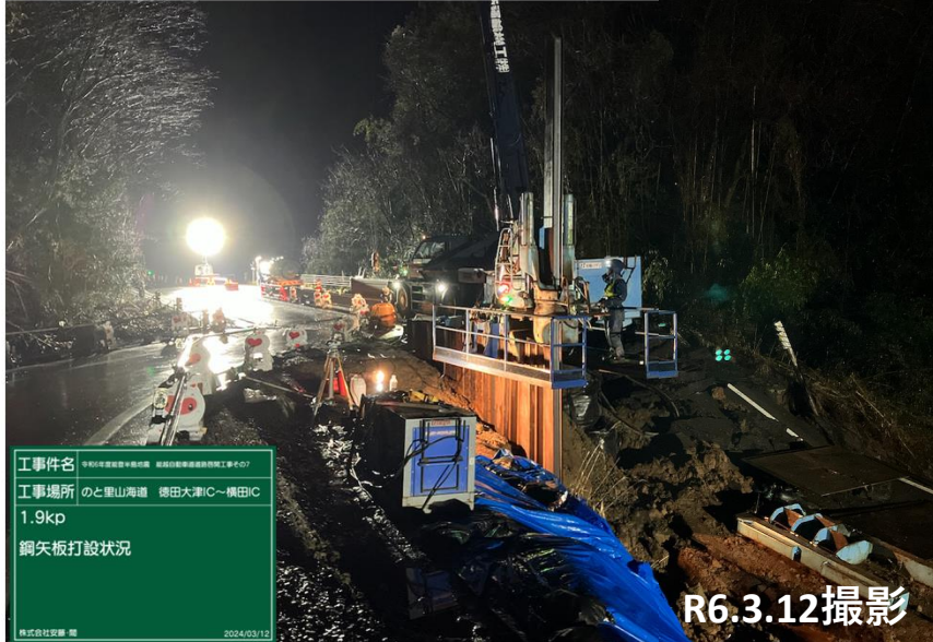
No. 2 鋼矢板打設状況
