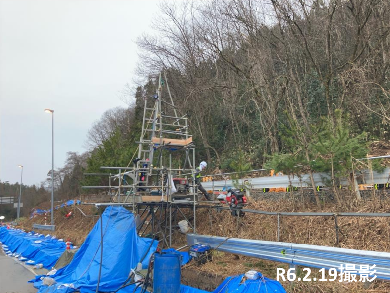
No.33 ボーリング調査状況
