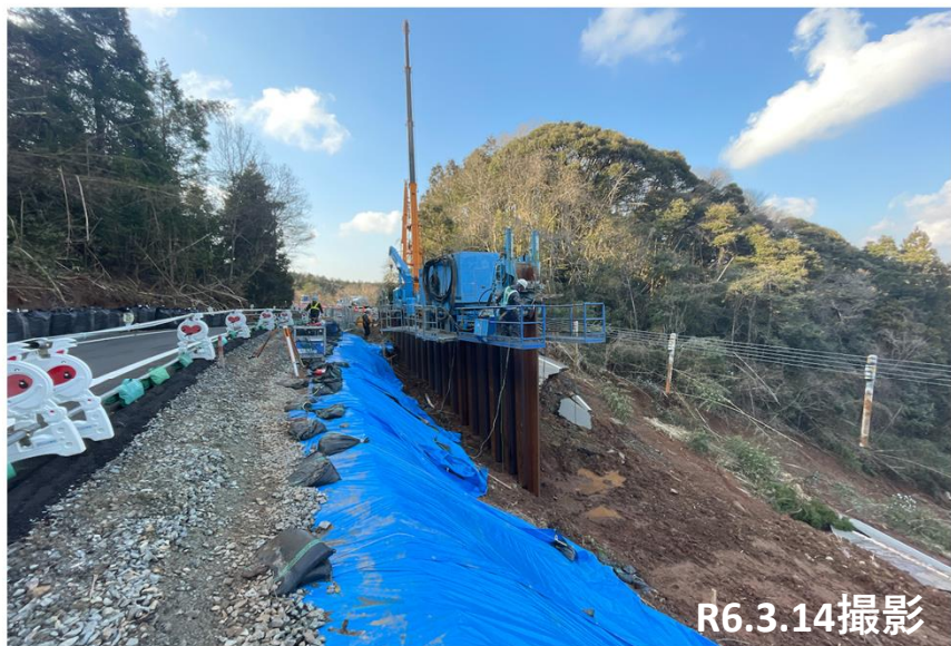
No. 2 鋼矢板打設状況
