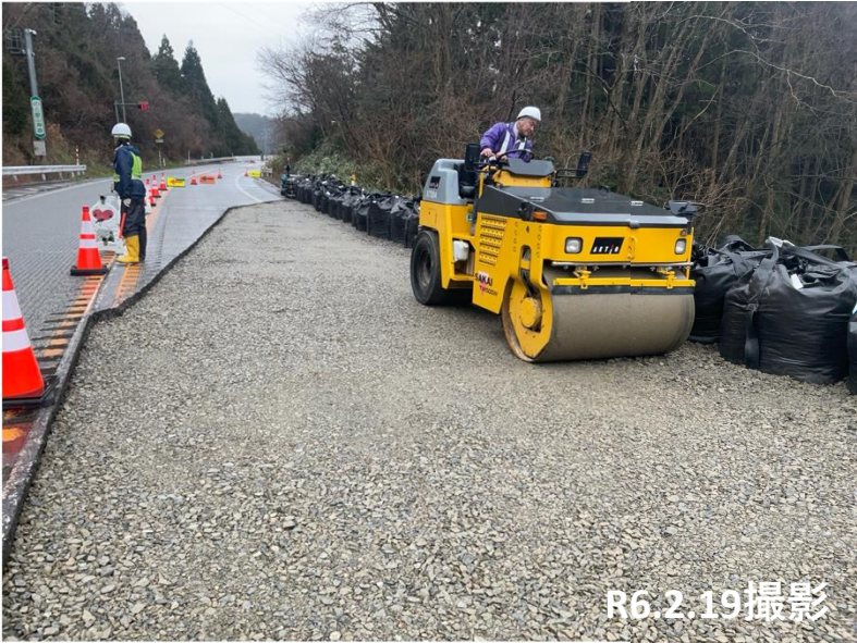
No.21 碎石敷均し状況
