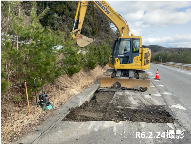
No.35 砕石敷均し状況
