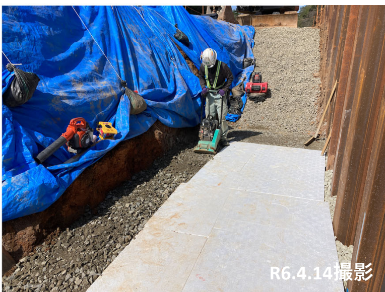
No.33付近 鋼矢板打設状況
