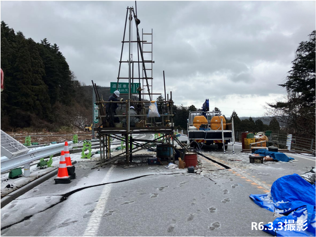
No.18 ボーリング調査状況
