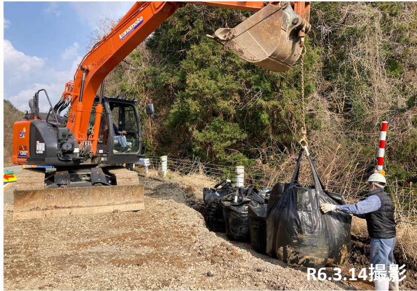
No.17 不陸整正 大型土嚢設置状況
