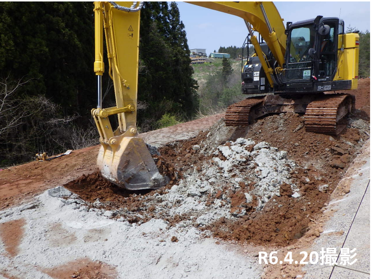
No.15付近 路床改良状況
