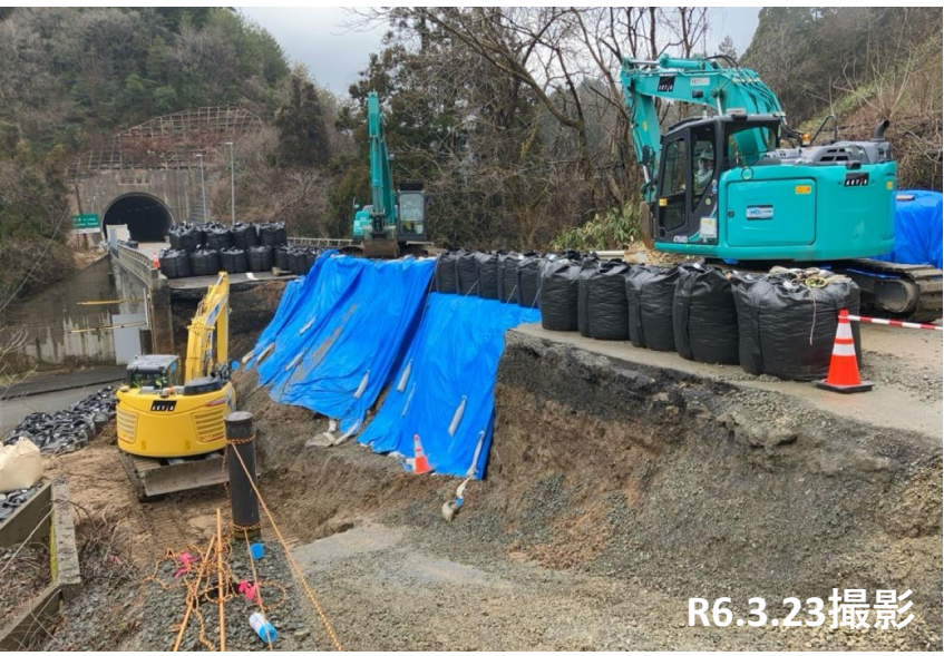
No.51 大型土嚢設置、碎石投入・転圧状況
