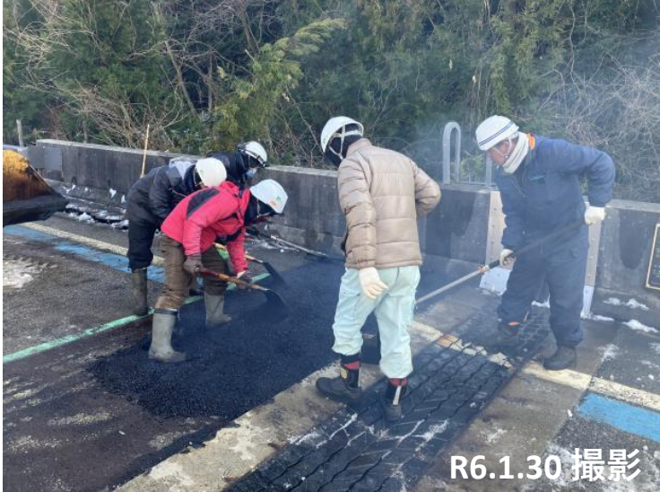
No32 舗装状況
