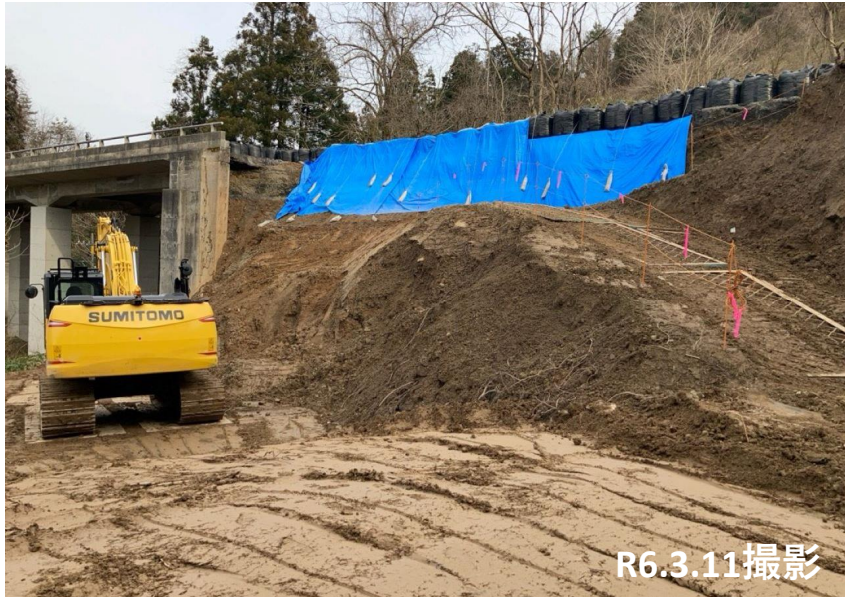
No.51付近 崩落箇所埋戻し状況
