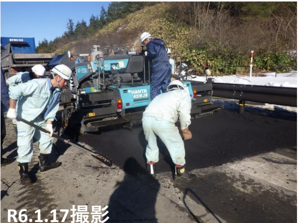
No.6 段差復旧状況
