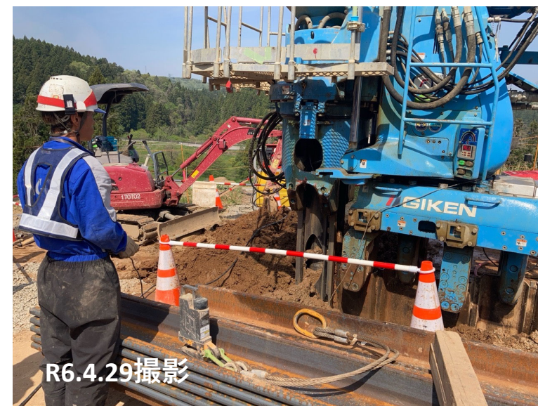
No.44付近 鋼矢板打設状況
