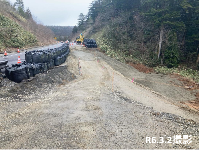
No.44付近 路盤不陸整正転圧状況
