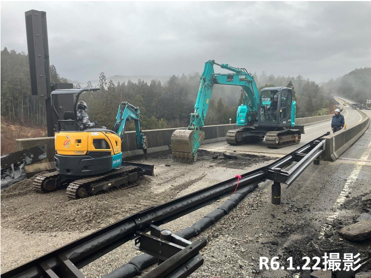
No41～42 段差復旧状況
