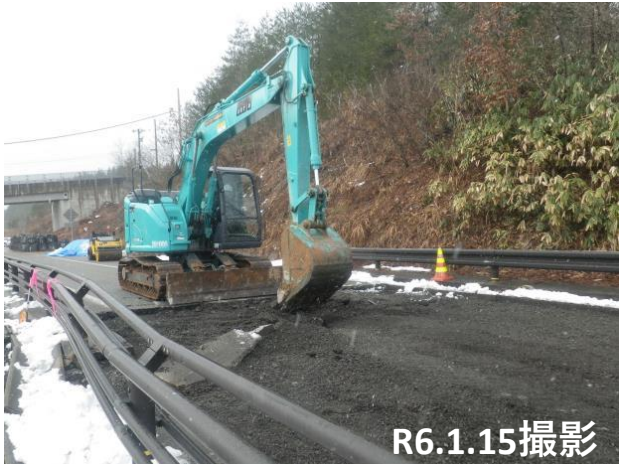
No.6段差復旧状況
