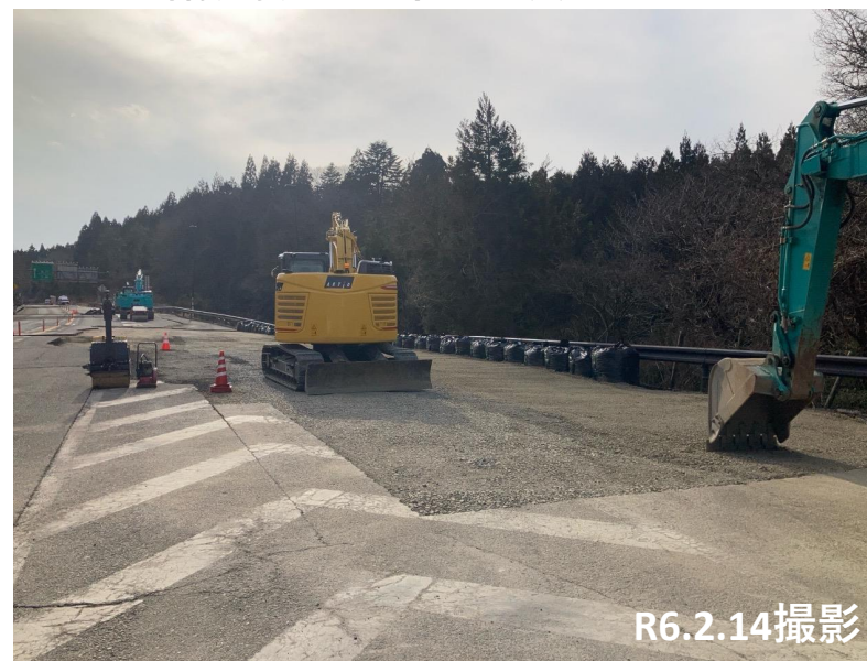
No.56 舗装撤去・砕石埋戻し
