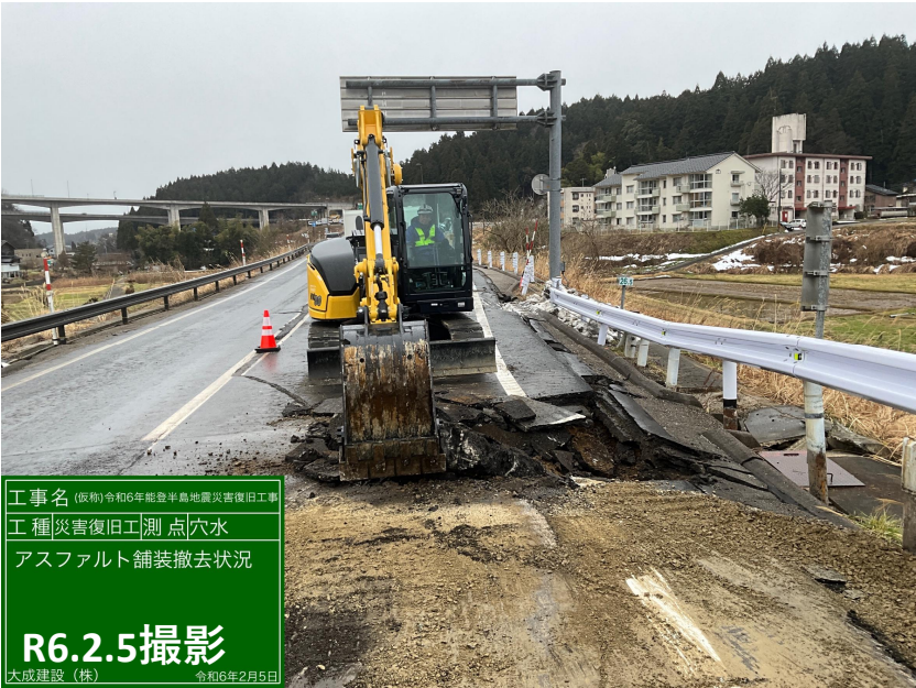
No.42付近 舗装撤去状況
