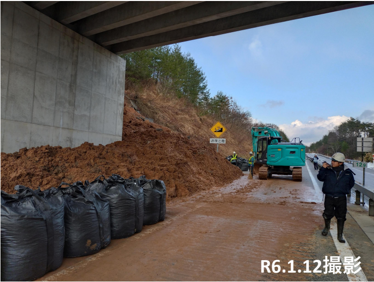
No.6 掘削・土嚢設置状況
