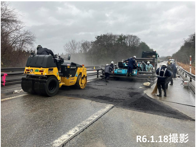
No.6 段差復旧状況
