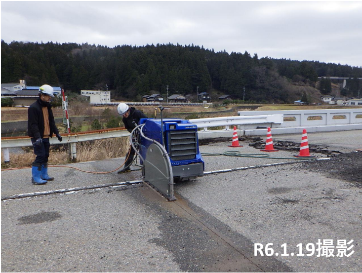
No.6 段差復旧状況
