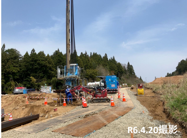
No.44付近 鋼矢板打設状況
