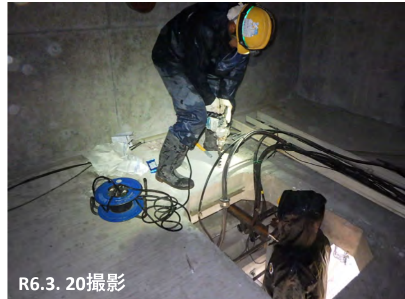
能登大橋 箱桁出入り口手掛り設置状況
