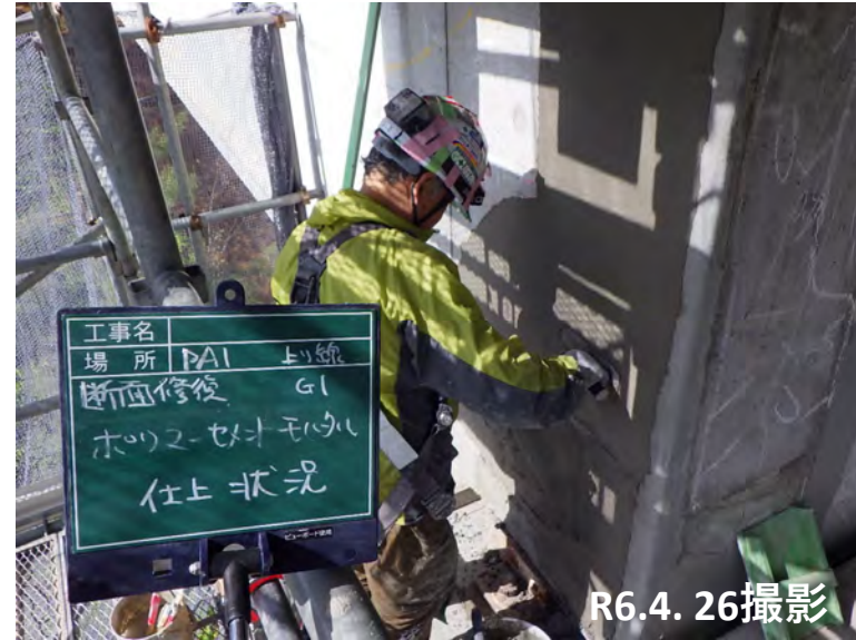
能登大橋・PA1橋台 T桁断面修復状況
