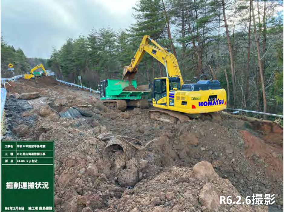
No. 49～50付近 掘削状況
