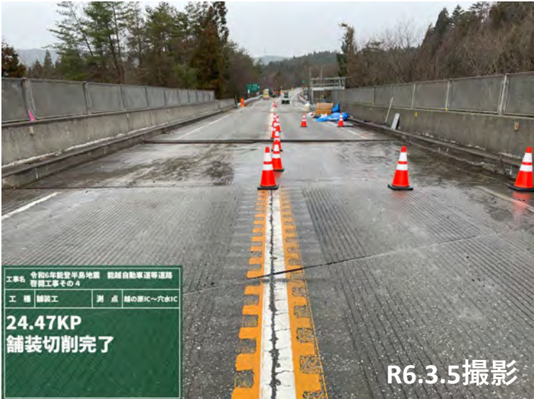
No. 55付近 舗装切削状況
