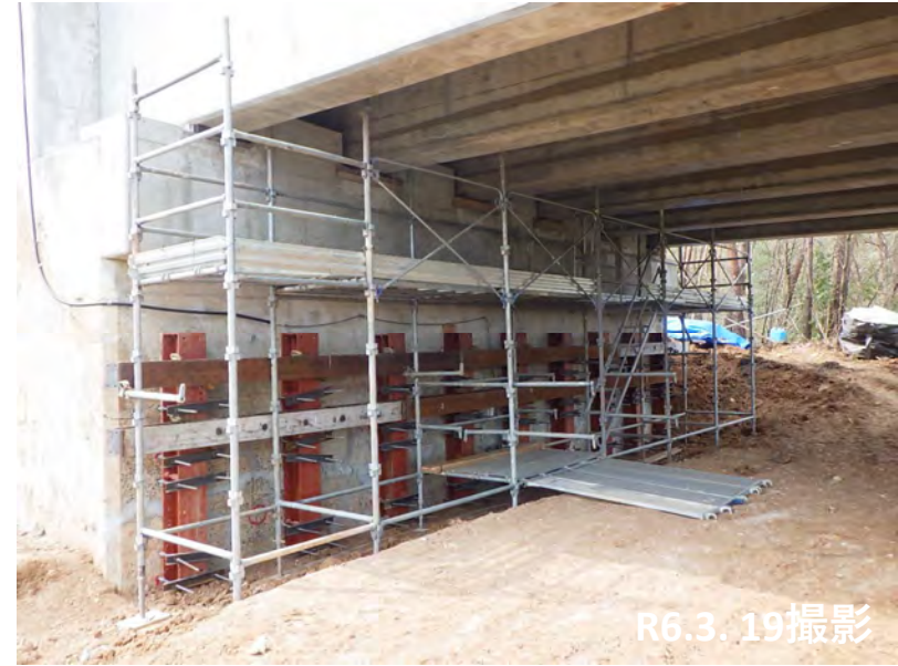
能登大橋 箱桁出入り口手掛り設置状況
