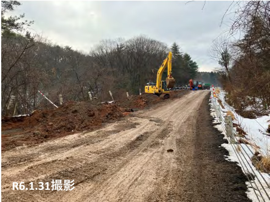
No.40路盤造成状況
