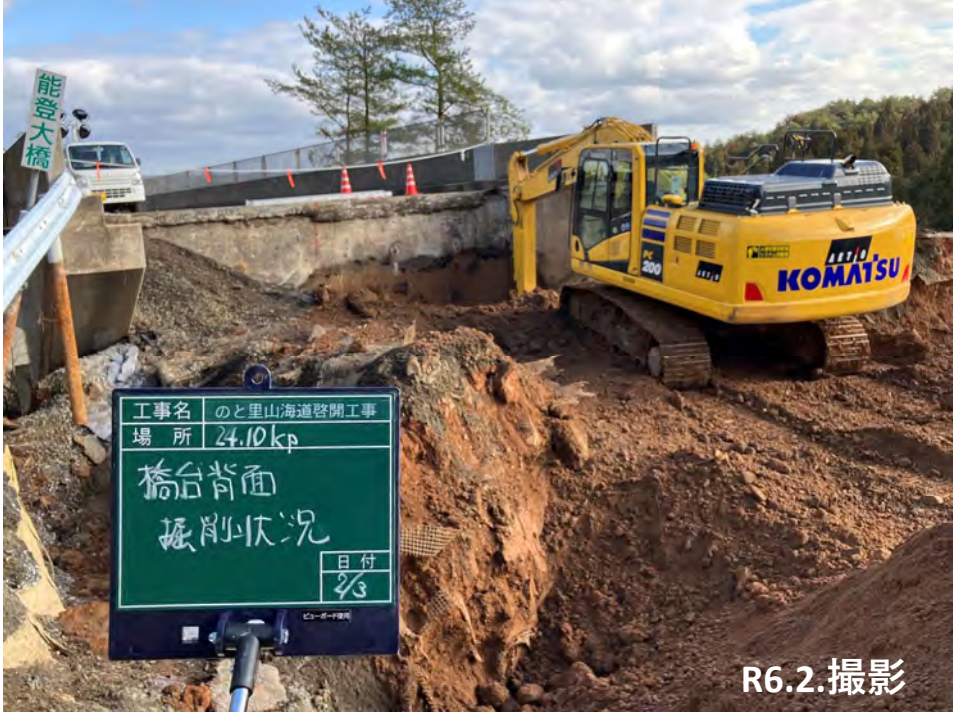
No. 50 橋台背面掘削状況
