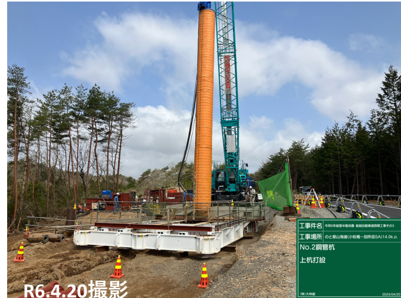
No.14 鋼管上杭打設状況
