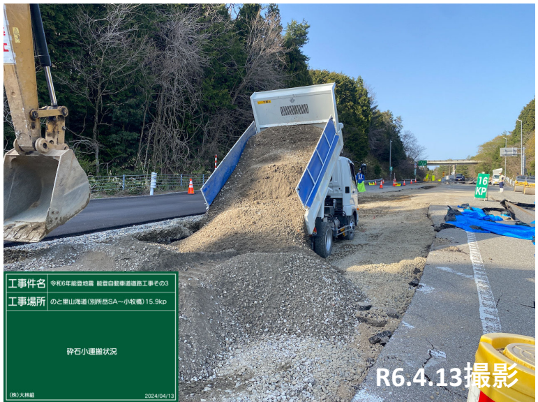
No.25付近 碎石小運搬状況
