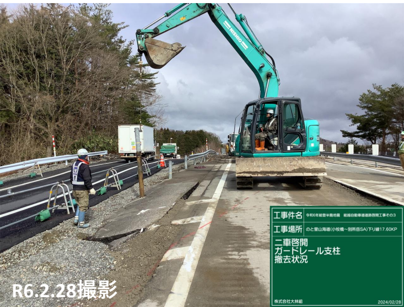
No.44 ガードレール支柱撤去状況
