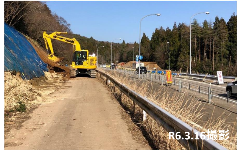
No.1付近 伐採作業状況
