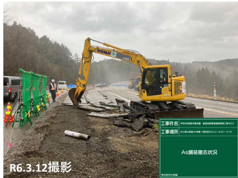
No.17 舗装撤去状況
