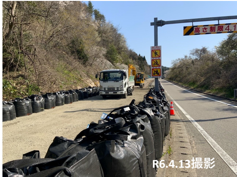
No.1付近 碎石敷均し状況
