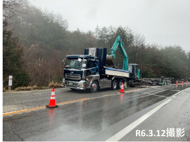
No.8 ガラ搬出状況
