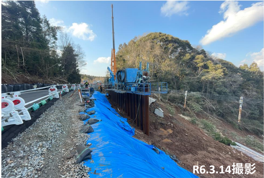
No. 2 鋼矢板打設状況
