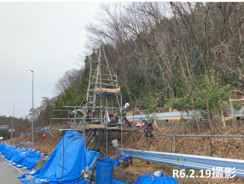
No.33 ボーリング調査状況
