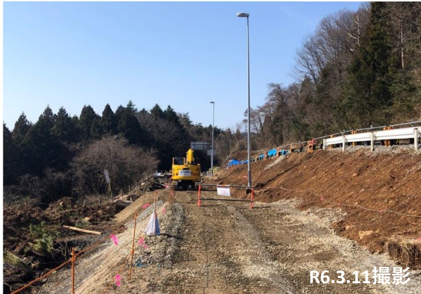
No.33 重機進入路造成状況
