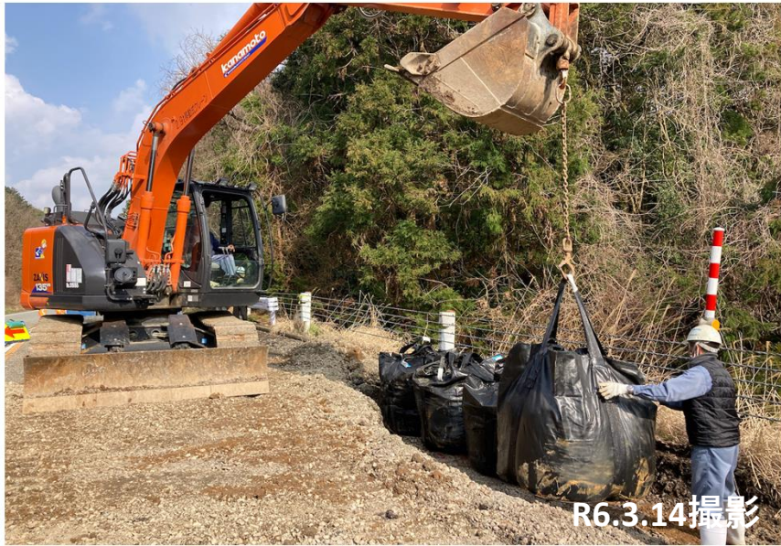
No.17 不陸整正 大型土嚢設置状況
