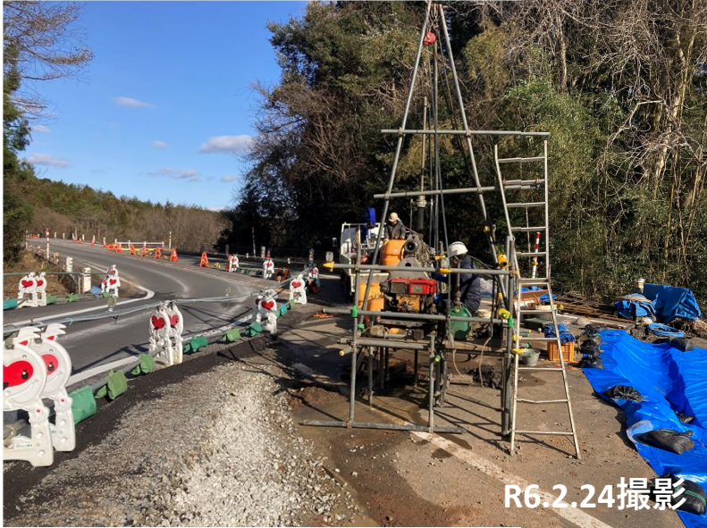
No.2 ボーリング調査状況
