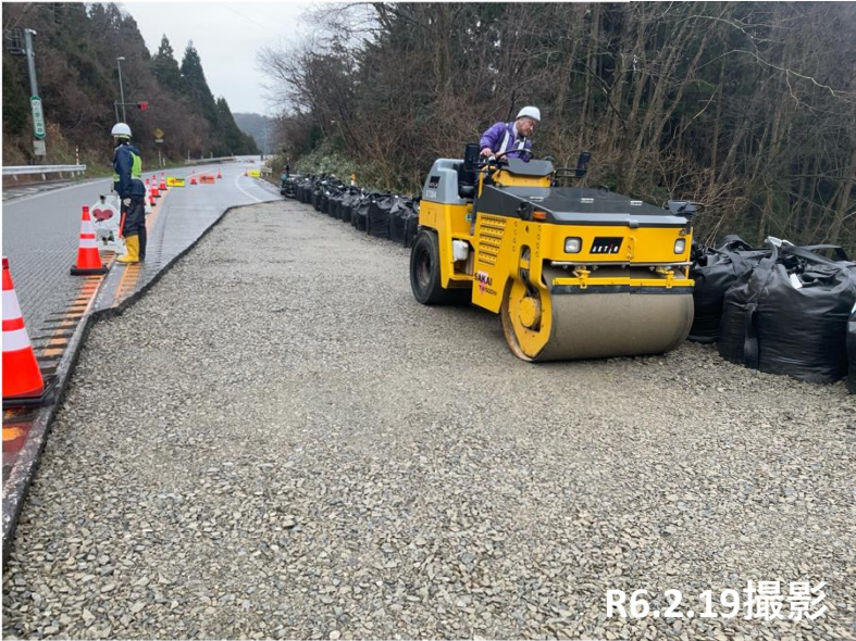
No.21 砕石敷均し状況
