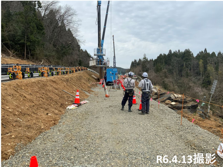
No.33付近 鋼矢板打設状況
