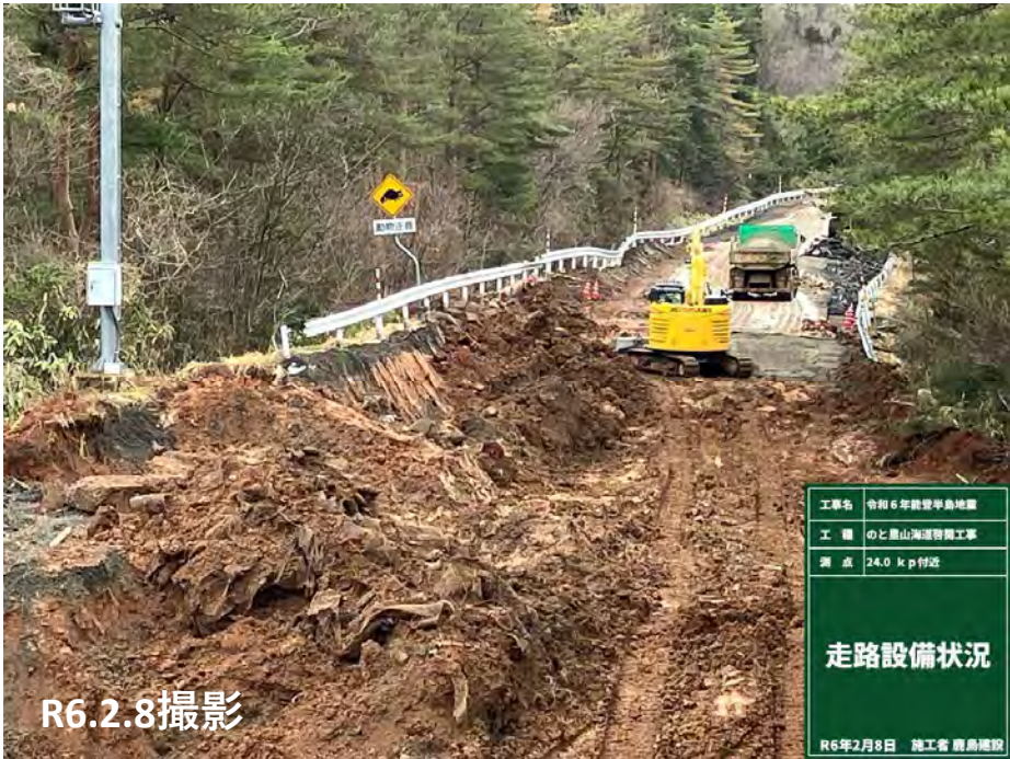
No. 47～50付近 走路整備状況
