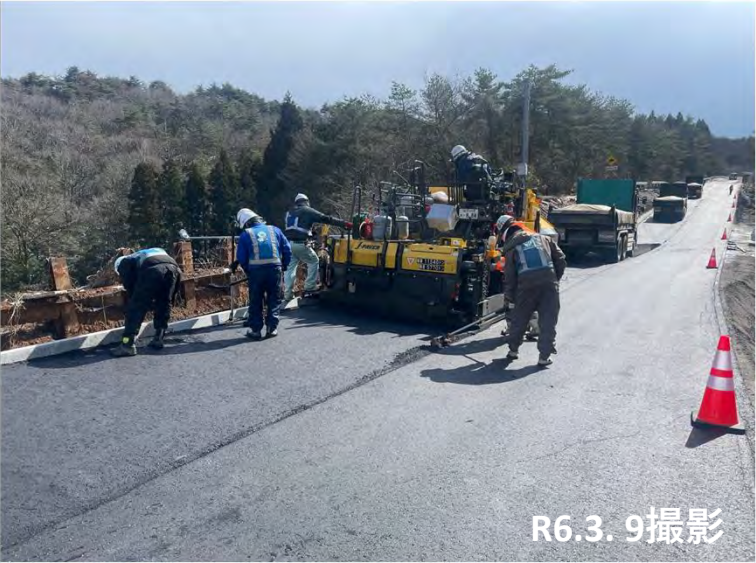
No. 45加熱合材施工状況
