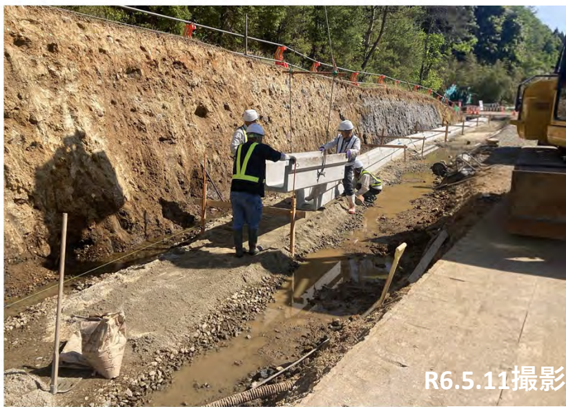
No.35 側溝設置状況
