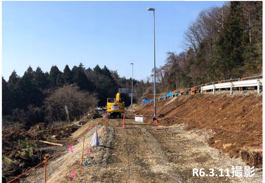
No.33 重機進入路造成状況
