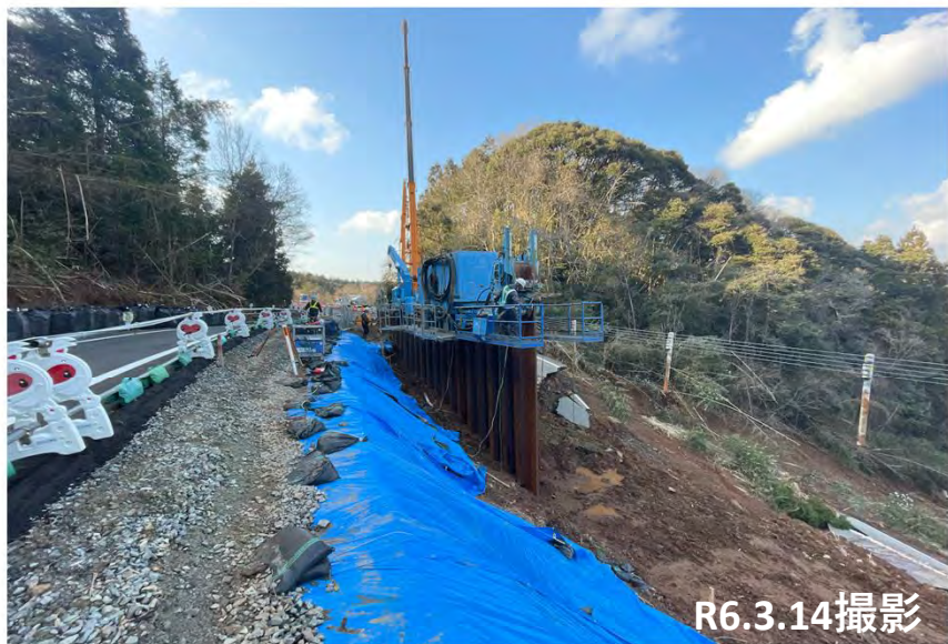
No. 2 鋼矢板打設状況
