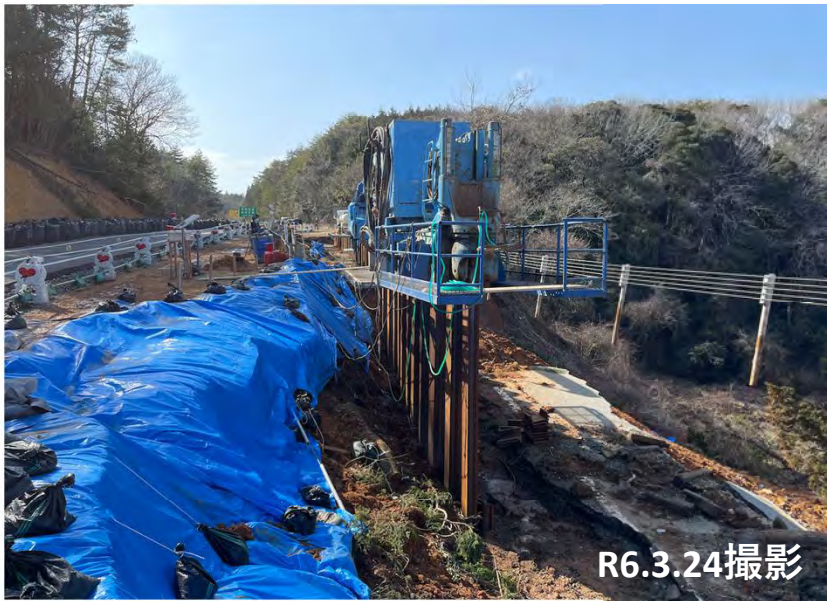
No. 5 鋼矢板圧入状況
