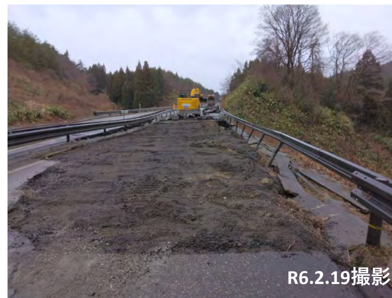
No.28付近 舗装撤去・砕石埋戻し状況
