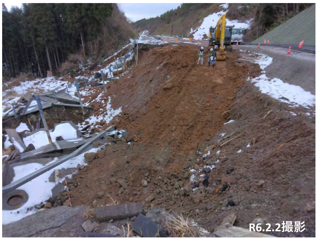
No.16 調査・整地状況
