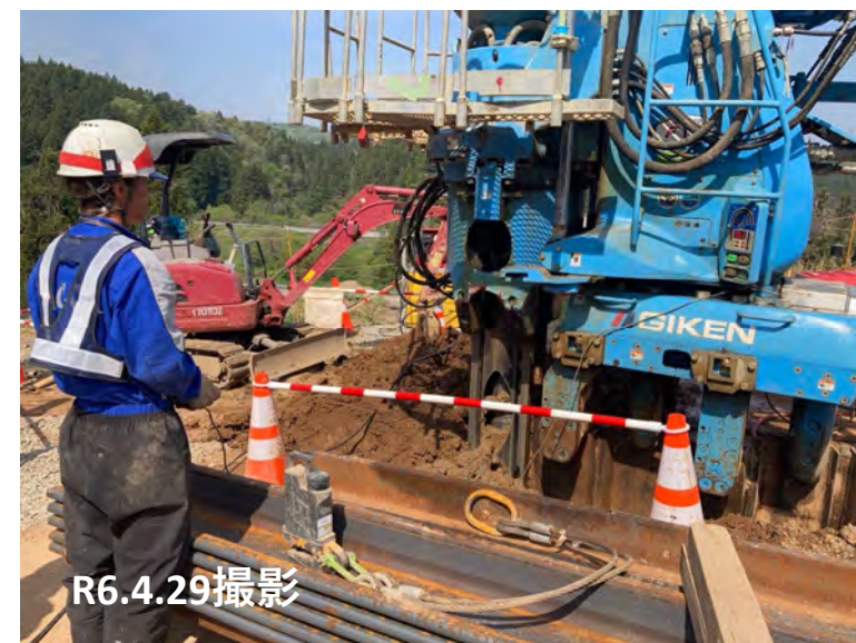
No.44付近 鋼矢板打設状況
