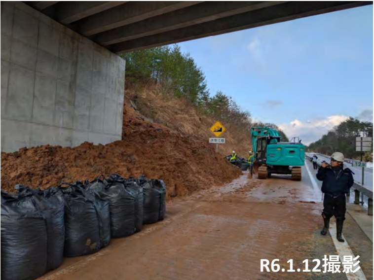
No.6 掘削・土嚢設置状況
