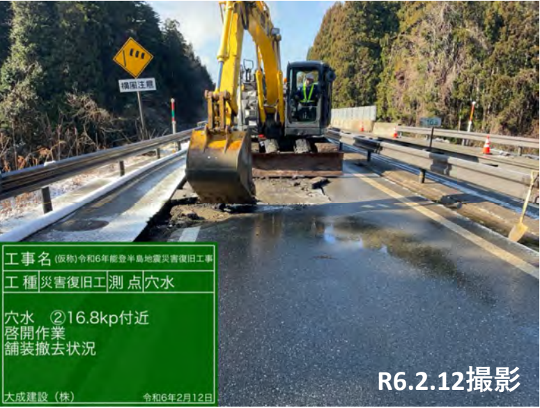
No.40 舗装撤去状況
