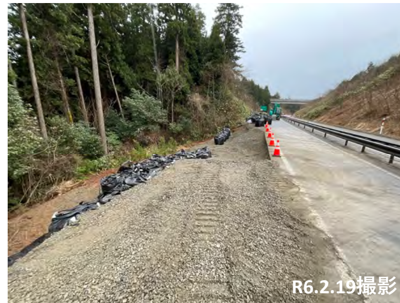
No.28付近 舗装撤去・砕石埋戻し状況
