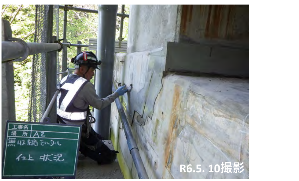
能登大橋・A2橋台(上り線側)地覆部断面修復状況
