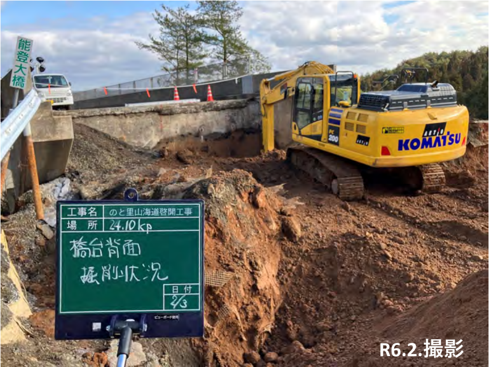
No. 50 橋台背面掘削状況
