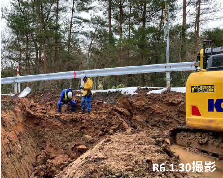
No.48詳細調査状況
