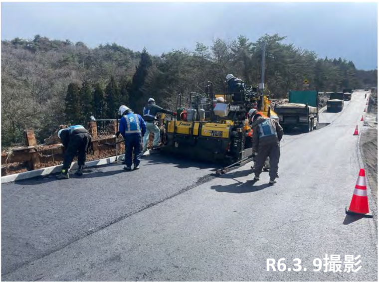
No. 45加熱合材施工状況
