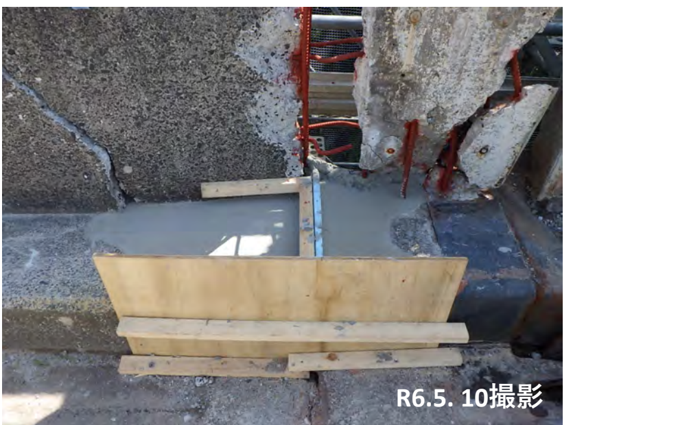
能登大橋・A2橋台(上り線側)地覆部断面修復状況
