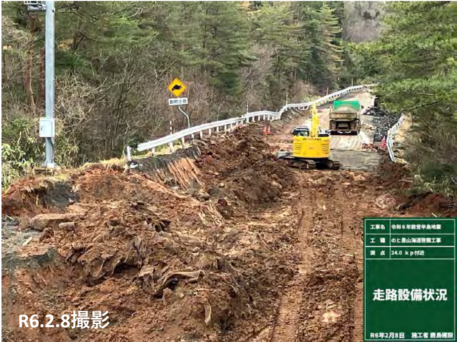
No. 47～50付近 走路整備状況
