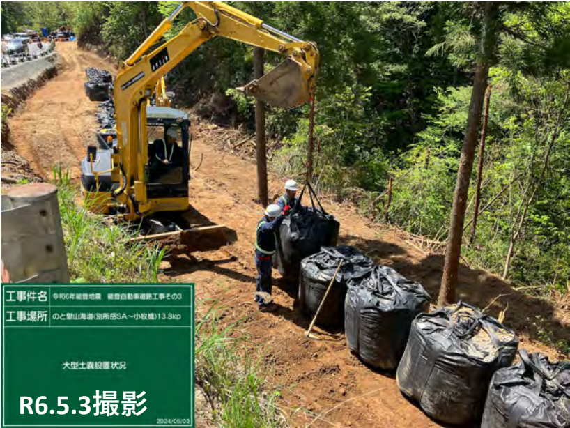
No.13 大型土嚢設置状況
